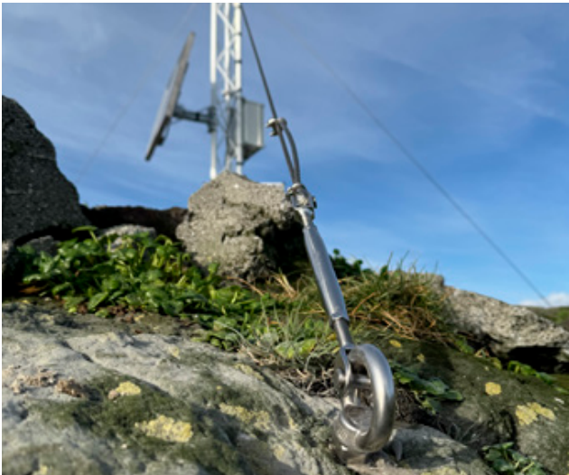
↑ Vitarnir eru rækilega festir niður, enda allra veðra von á þessum slóðum.
