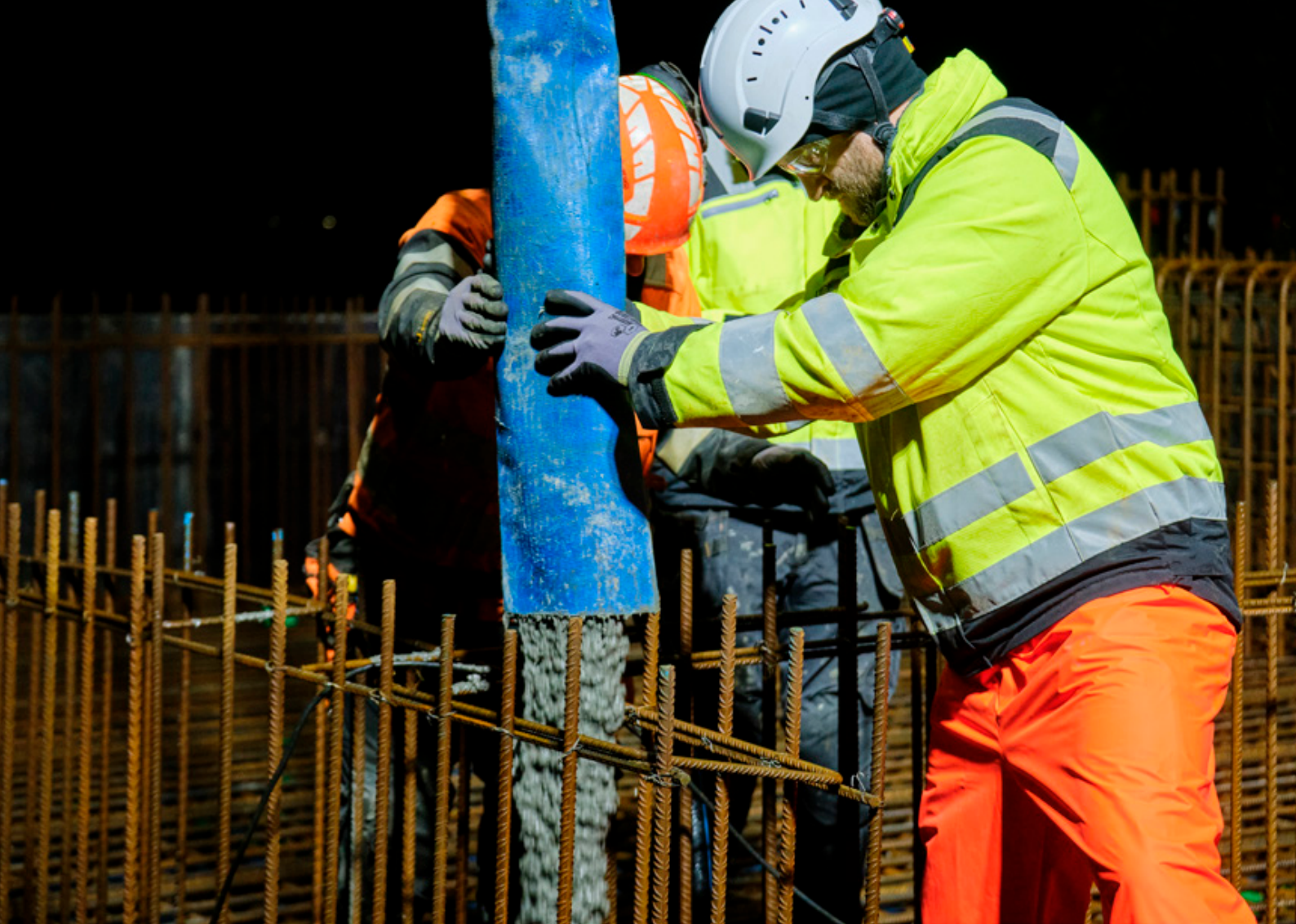
↑ Steypan rennur greiðlega en alls fóru um 400 rúmmetrar af steypu í undirstöðurnar.
