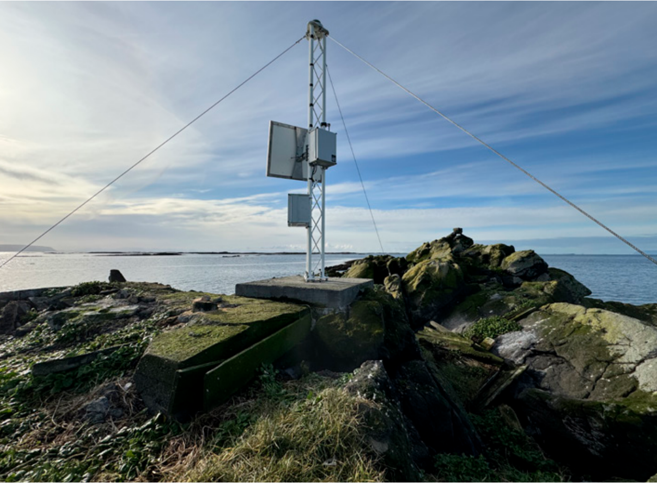
↑ Nýi Skarfaklettsvitinn er þriggja metra hár stálmastur, með sólarrafhlöðu, rafgeymum og merkjagjafa.
