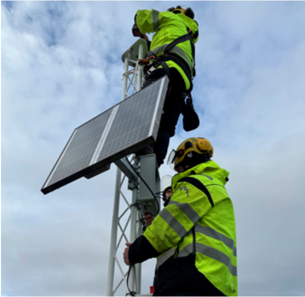
↑ Unnið að því að tengja merkið við aflgjafa við nýja Miðleiðarskersvita.
