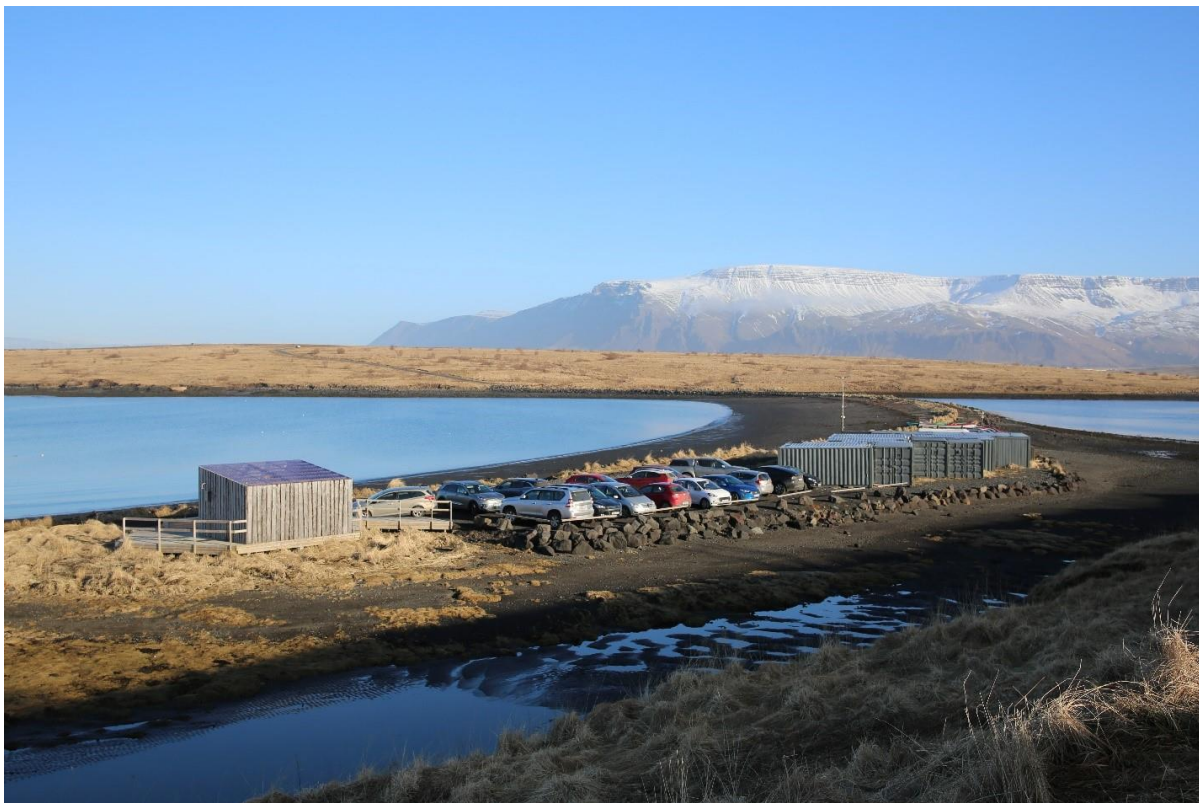
MYND 5.141 Aðstaða Kayakklúbbsins við Eiði. Mynd: EFLA, 2025.
