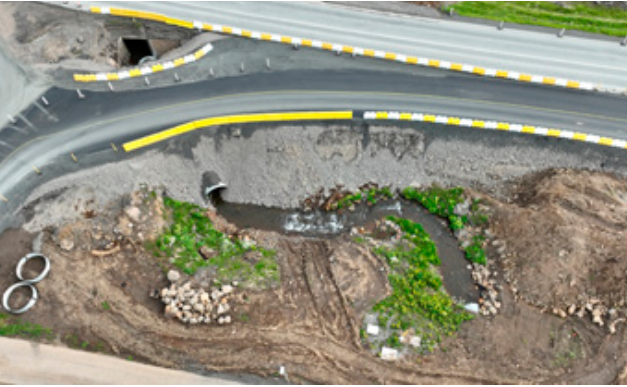
↑ Innifalið í verkinu er gerð á nýju ræsi fyrir Lónsá undir Hringveg en það mun liggja þvert undir nýja hringtorgið.
