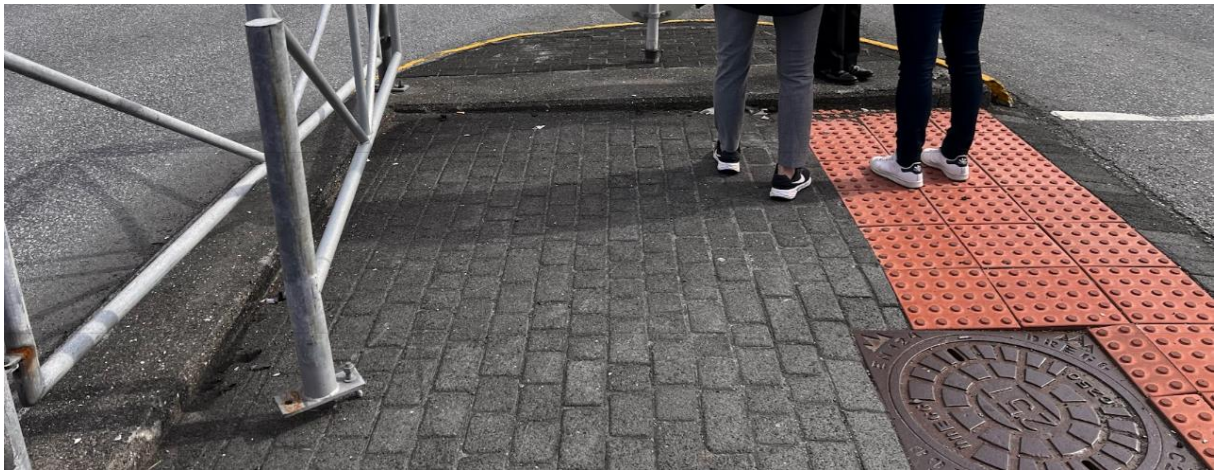
MYND 3 Árekstur á leiðigerði. Grindverkið losnaði af festingum og virðist hafa farið inn í gönguleiðina.
