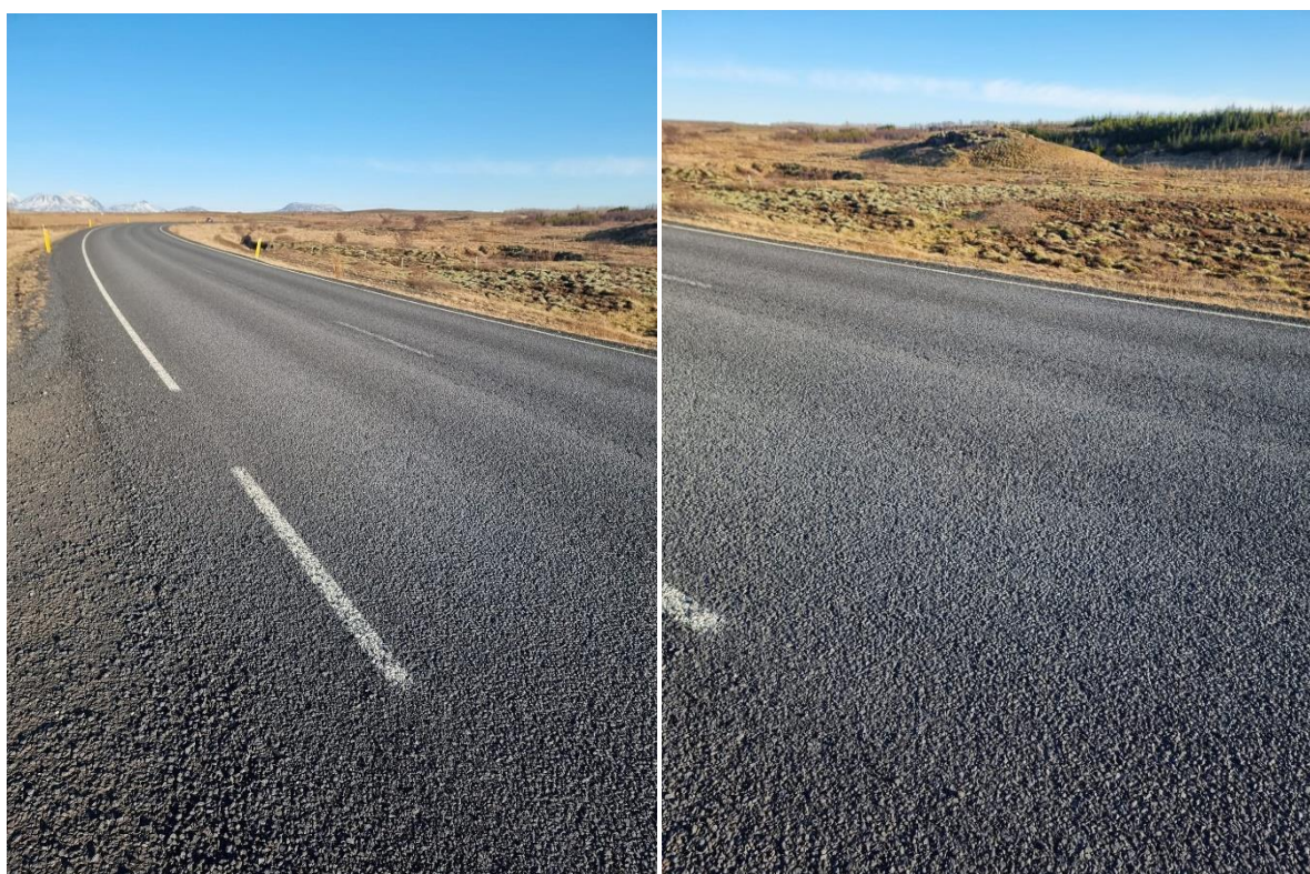
Mynd 3: Klæðingin eftir einn vetur, febrúar 2025
