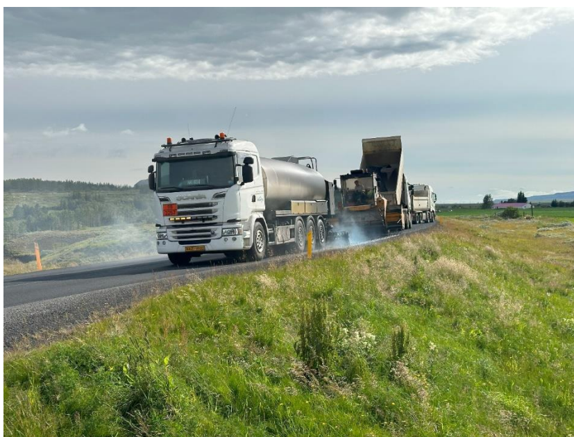
Mynd 1: Borgarverk að störfum við útlögn á klæðingunni.
