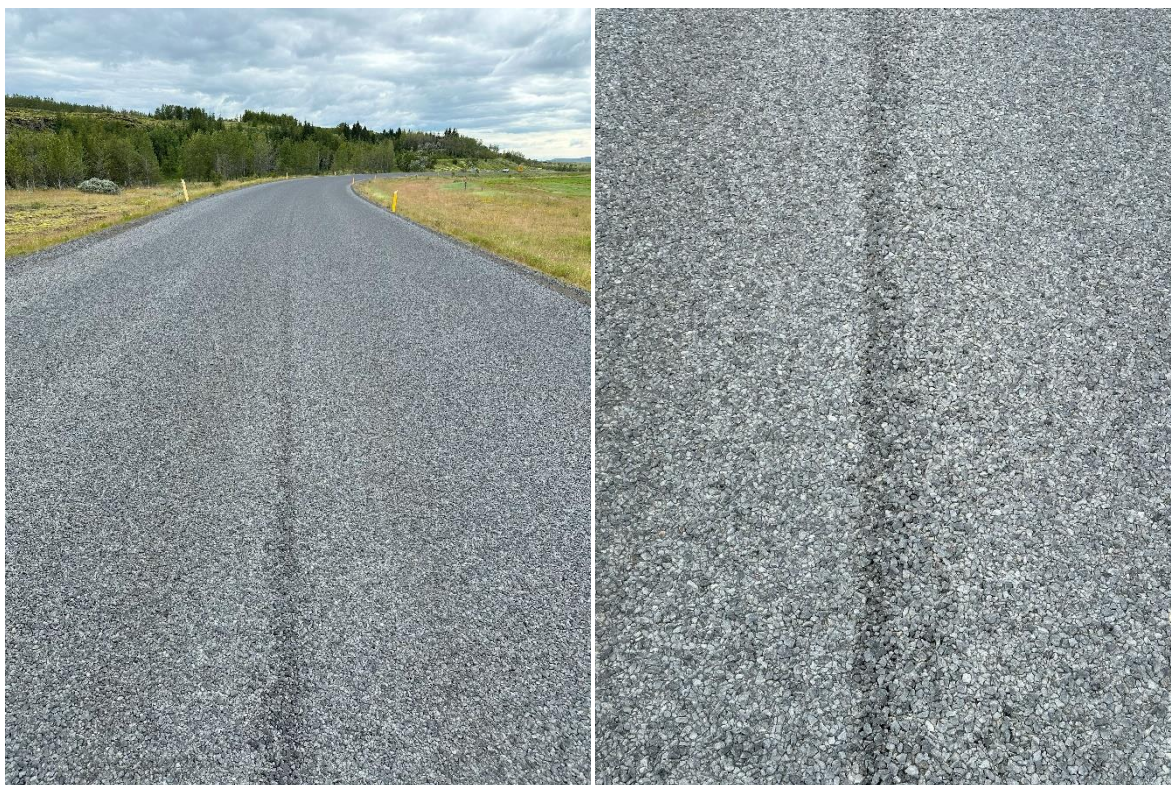
Mynd 2: Nýlögð klæðing eftir sópun, ágúst 2024
