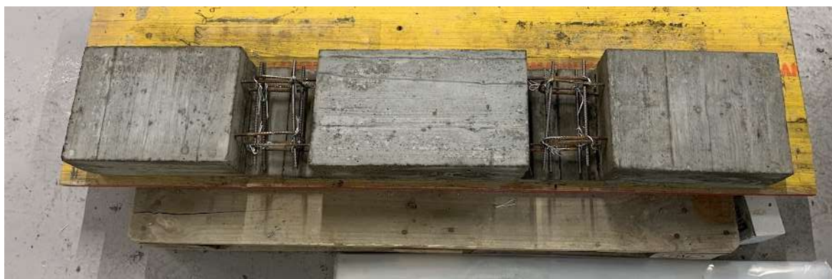
Mynd 28: Tenging tilbúin fyrir samsteypu
