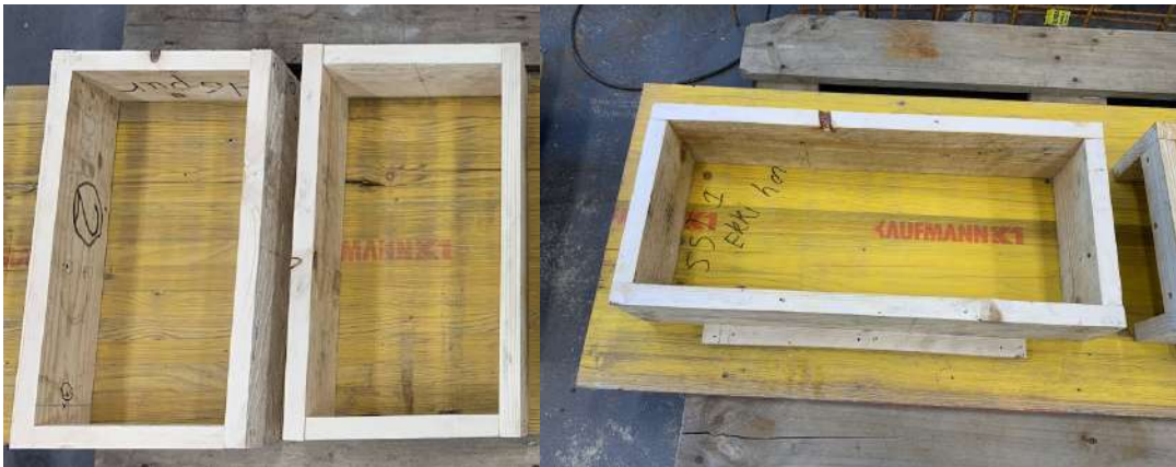
Mynd 20: Mót fyrir skúffutenginguna
