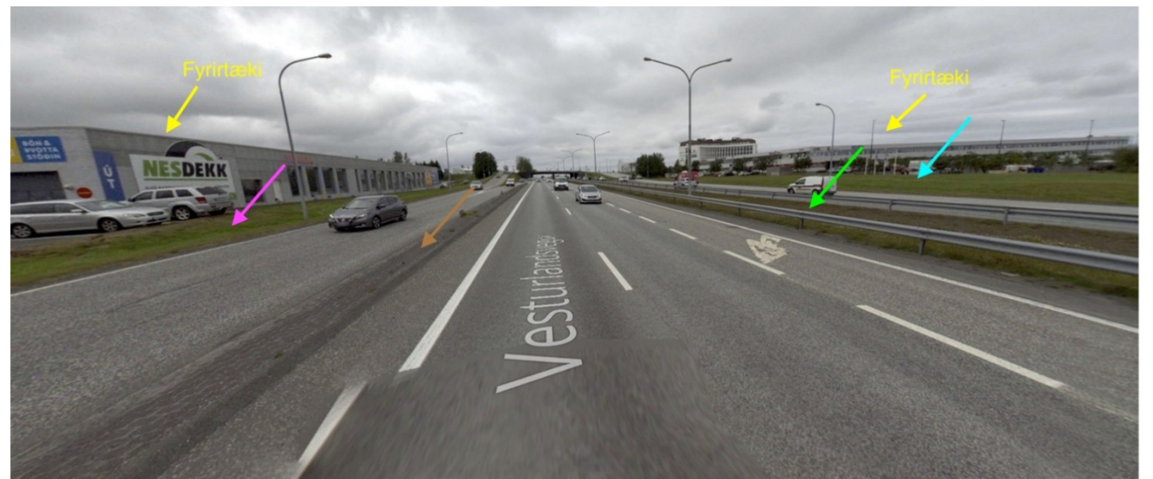
Mynd 27. Vesturlandsvegur, séð í átt að Höfðabakka (Já hf., 2023). Til vinstri sést steiptan miðdeili sem aðskilur Vesturlandsveg frá innakstri að fyrirtækjum við Hálsa. Nákvæm staðsetning myndarinnar miðað við mynd 24, er sýnd í viðauka 4.
