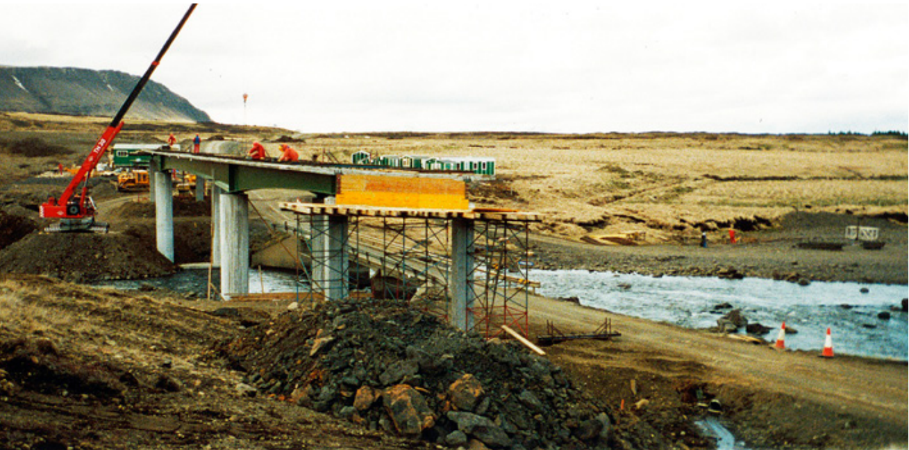
↑ Brúarflokkurinn á Hvammstanga byggir brú á Flókadalsá í Borgarfirði.
