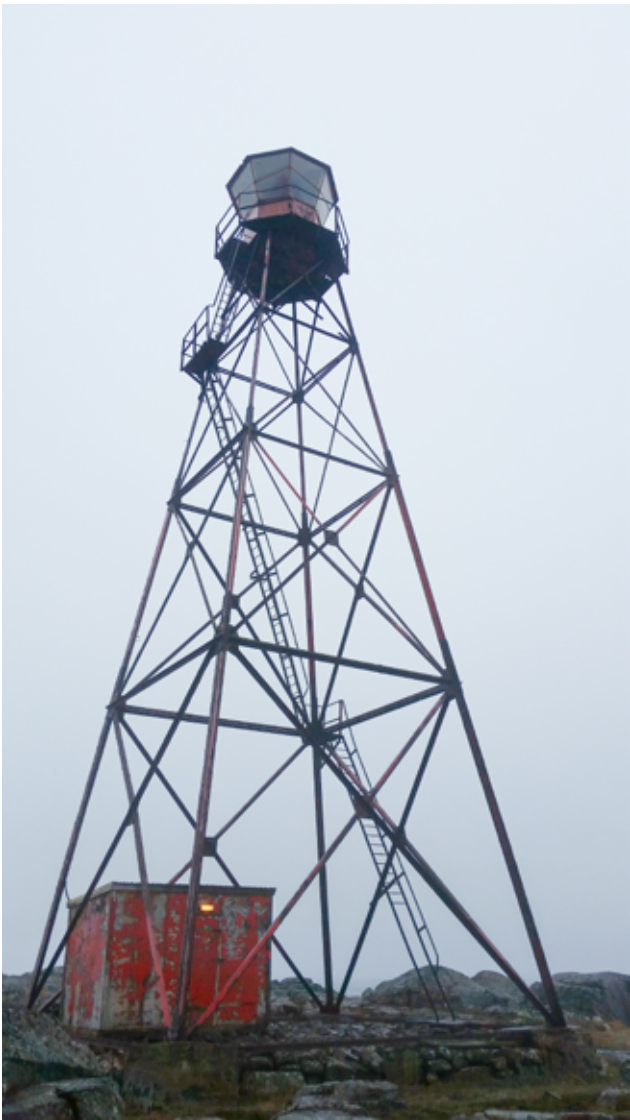
Gjögurviti var 24 metra hár stálgrindarviti sem reistur var á Gjögri á Ströndum árið 1921.
