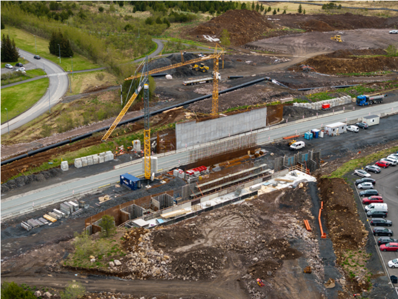
↑ Við Arnarnesveg er unnið í nálægð við þunga umferð og mikilvægt að ökumenn virði hraðatakmarkanir í gegnum vinnusvæði. Mynd: Vilhelm Gunnarsson.
