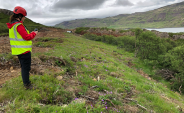
↑ Strax á fyrsta ári var vegfláinn gróskumikill og gaf náttúrulegt útlit með tegundum úr skógarbotninum í gróðurtorfum sem voru lagðar út snemma um vorið. Myndin er tekin í júní 2023 af Steinunni Garðarsdóttir og sýnir Huldu Birnu Albertsdóttur í gróðureftirliti.
