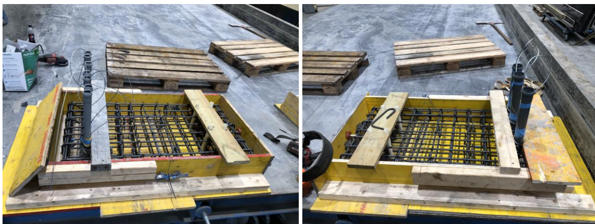
Mynd B 3: Steypumót veggja klár fyrir steypuvinnu. Hér sitja þau á gólfi BM Vallarétt fyrir steypuvinnu.
