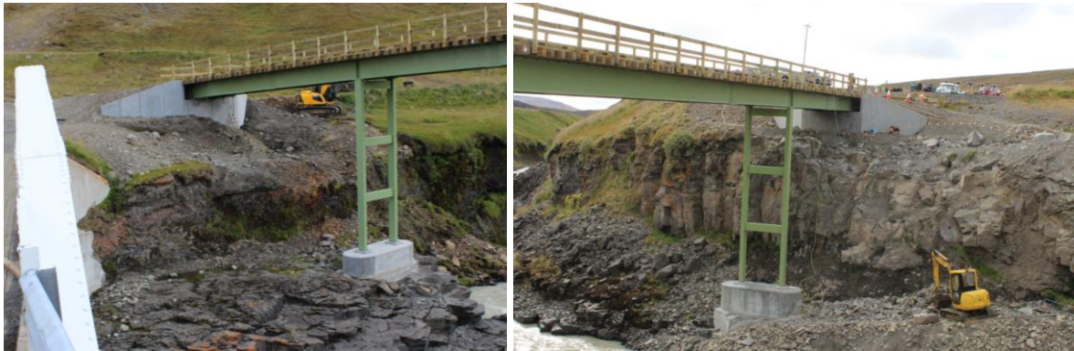
Mynd 1-3: Austurstöpull (vinstri) og vesturstöpull (hægrri) brúar yfir Jökulsá á Dal (Vegagerðin).
