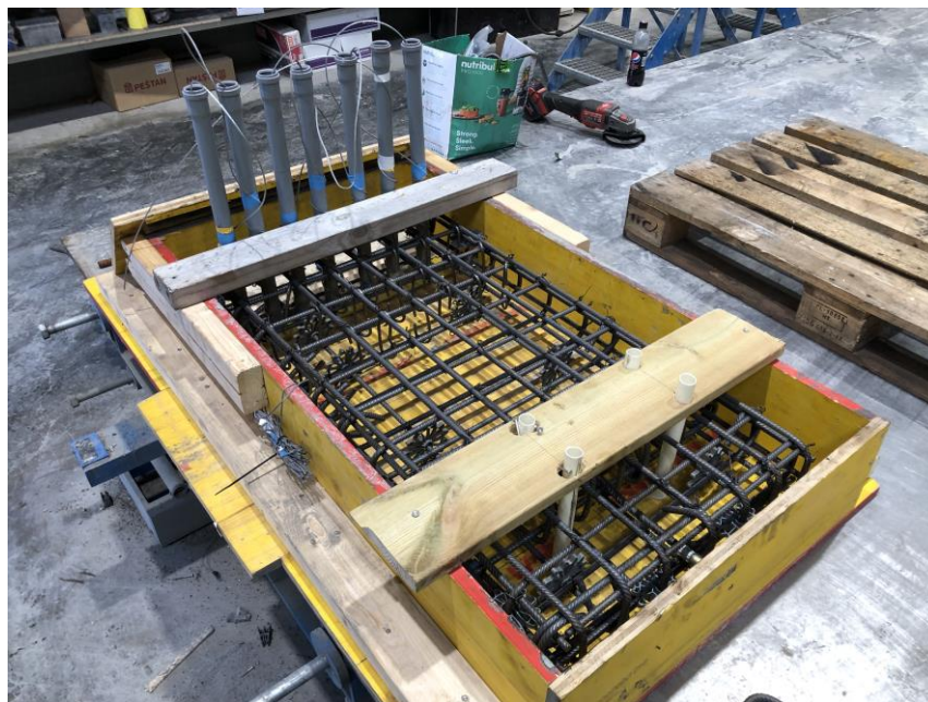
Mynd 2-13: Veggeining fyrir FSL-LS klár til steypu. Rörin sjö eru fyrir K10 járnin sem þrædd verða í gegn eininguna.
