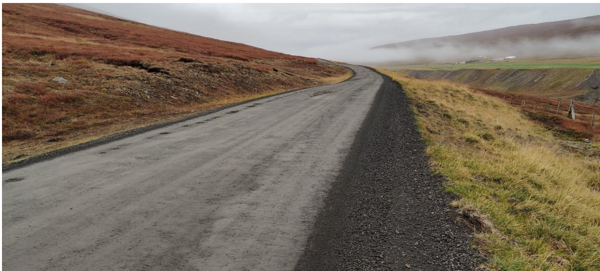
Mynd 3: Núverandi vegur séð til norðurs frá verkmörkun í st. 8700.
