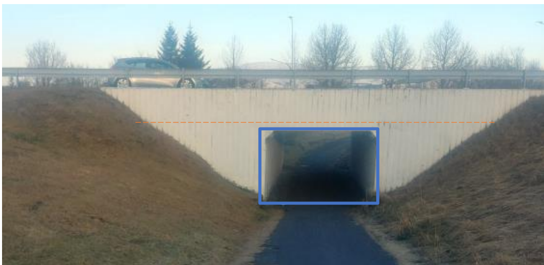
Núverandi undirgöng undir Breiðholtsbraut við Jaðarsel.
