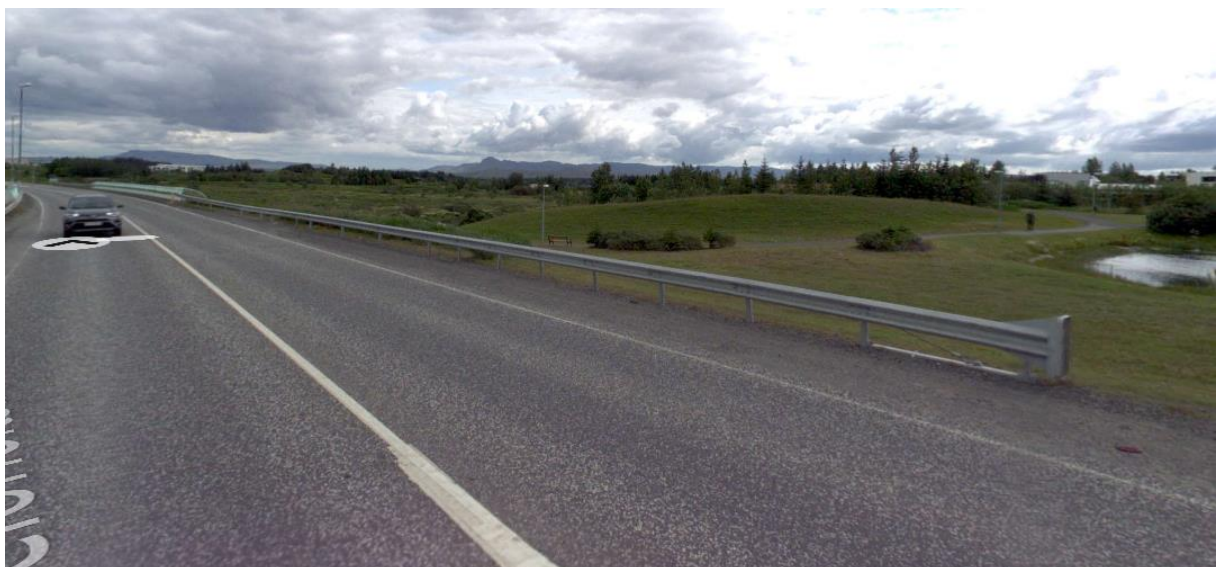
Núverandi bitavegrið við vegöxl meðfram Breiðholtsbraut áður en komið er að brú yfir Elliðaár. Færa þarf hluta vegriðs lengra til austurs (mynd af já.is).
