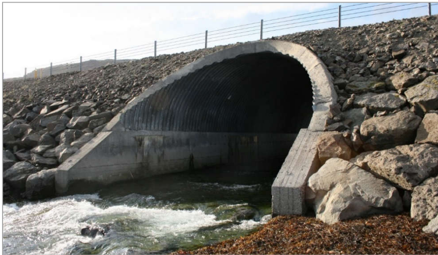
Mynd 6.7.3. Þverá í Vatnsfirði, stálræsi með steiptum undirstöðum og hálfhring yst (mynd: Aron Bjarnason, 2014).
