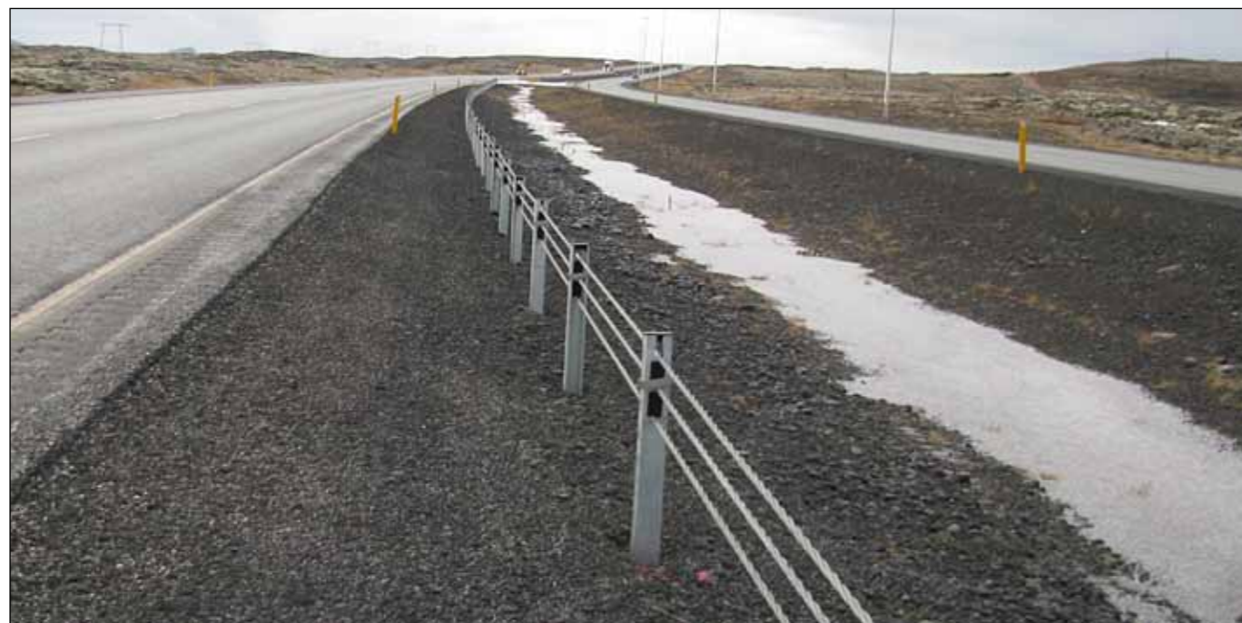
Víravegríð við Reykjanesbraut. Lokið er uppsetningu á 8,6 km. Væntanlega verður framhald á verkinu boðið út í ár.
