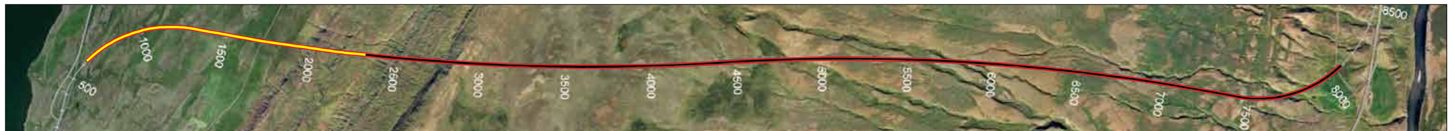
Vaðlaheiðargöng, staða framkvæmda 3. febrúar 2014. Búið er að sprengja 1.682 m frá Eyjafirði sem er 23,5% af heildarlengd.
