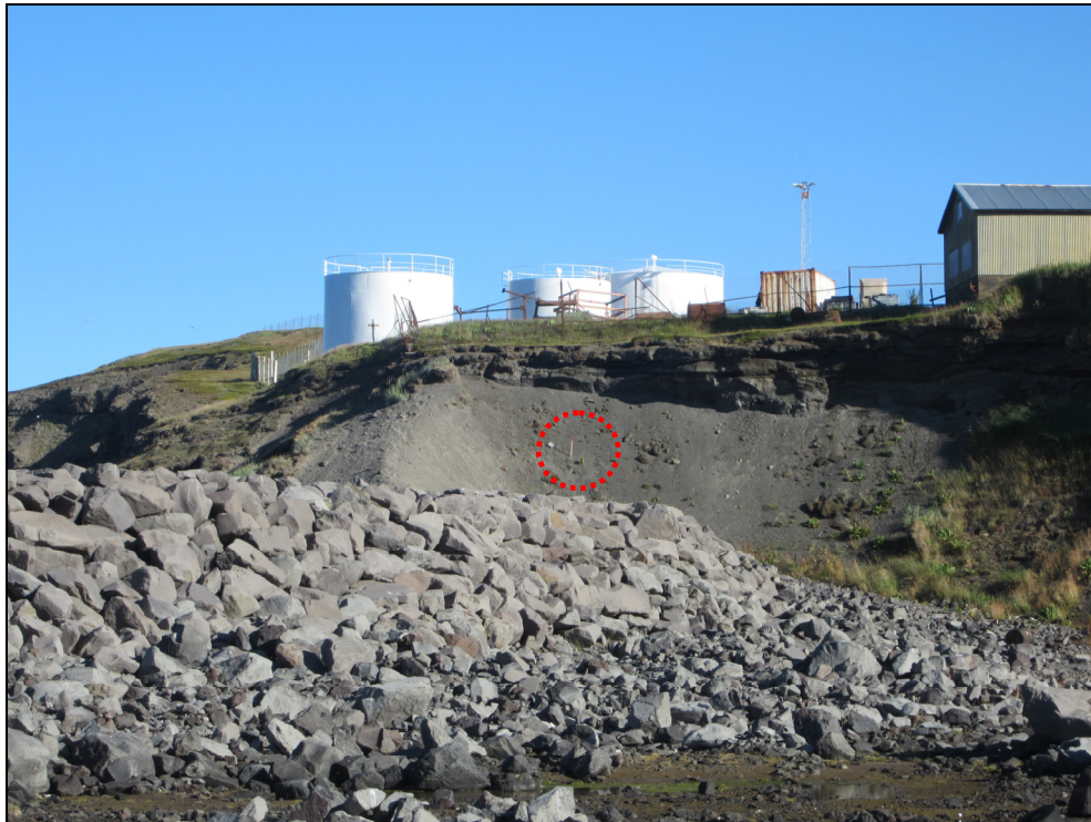
Ljósmynd 5. Munnasvæði við Bökugarð. Hæll í fláa fyrir miðri mynd er miðlína vegar. Forskering yrði grafin um 80 m nær oliutönkum og gangamunni þar. Hálsamlímt siltsteinsvöluberg í bakkanum.
