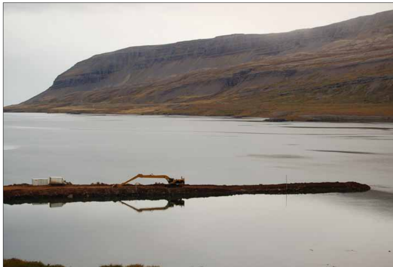
Vestfjarðavegur (60), Eiði - Þverá. Framkvæmdir í Kjálkafirði. Þegar fyllingar eru lagðar þarf sérstaklega að gæta að sigi. Fyllinguna þarf að leggja út í lögum til að botninn brotni ekki og efni tapist. Þess vegna var gert ráð fyrir að fyllingarnar í Mjóafirði og Kjálkafirði yrðu báðar lagðar út með pramma á sjó. Kjálkafjörður er grynri og fékk verktakinn heimild til að prófa að leggja fyllinguna út með löngum gröfjuarmi. Grafan nær 20 metra framfyrir sig og til hliðanna. Þetta hefur gengið vel en mjög vel er fylgst með sigi. Fyllingin hefur lengst um 5-8 m á dag. Sigurður Mar Óskarsson tók myndir á forsiðu og baksíðu 20. september 2012.
