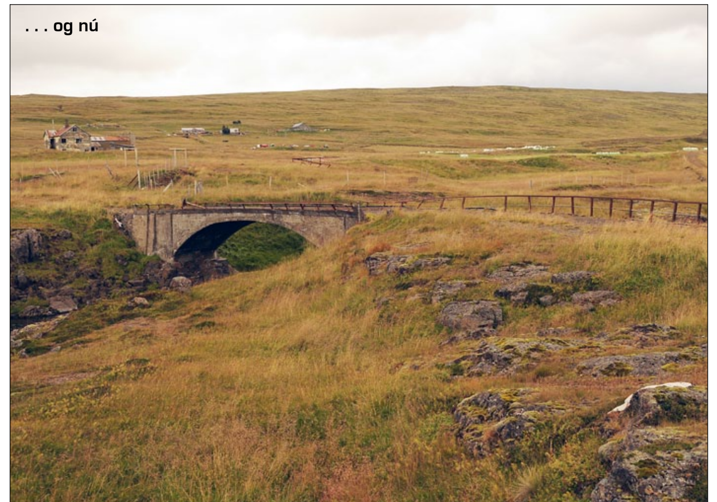
Vestfjarðavegur (60), Haukadalsá í Dölum. Gamla brúin stendur enn og þjónar sem göngubrú. Leifar af fornu vegriði eru athyglisverðar minjar. Litlu neðar í ánni er einbreið bogabrú sem nú er ekið yfir, byggð 1971. Eyðibýlið í baksýn heitir Aflstaðir. Gamla myndin er úr safni Jóns J. Víðis.
