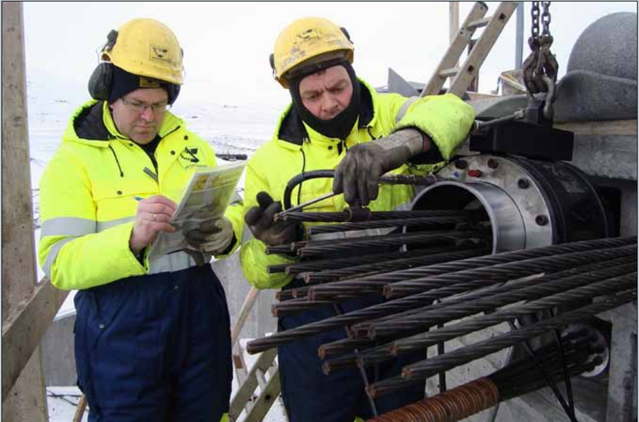
Brú yfir Reykjadalssá í Dalasýslu. Spennukaplar strektir 19. mars 2014. Sigurður Hallur Sigurðsson og Guðjón Valgeir Guðjónsson starfsmenn í brúarvinnuflokki Vegagerðarinnar frá Hvammstanga.
