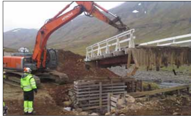
Yfirbyggingin hóf af stöplunum.
