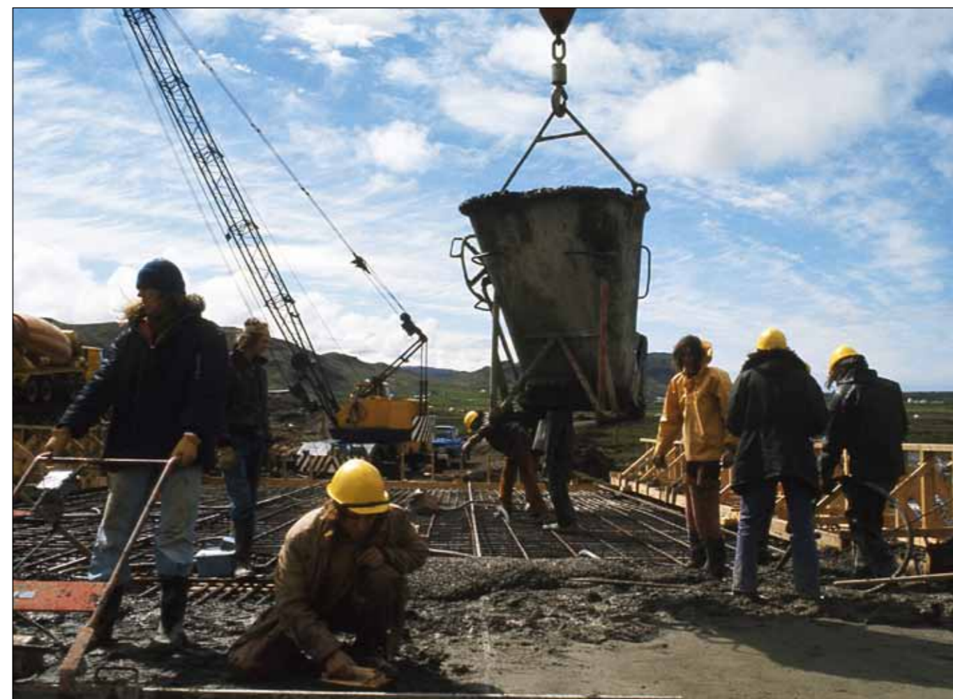
Brúarvinnuflotkur Huga Jóhannessonar að steypa brúardekk á Köldukvísl hjá Gljúfrasteini í Mosfellsdal árið 1974. Ljósmynd: Ímynd.
