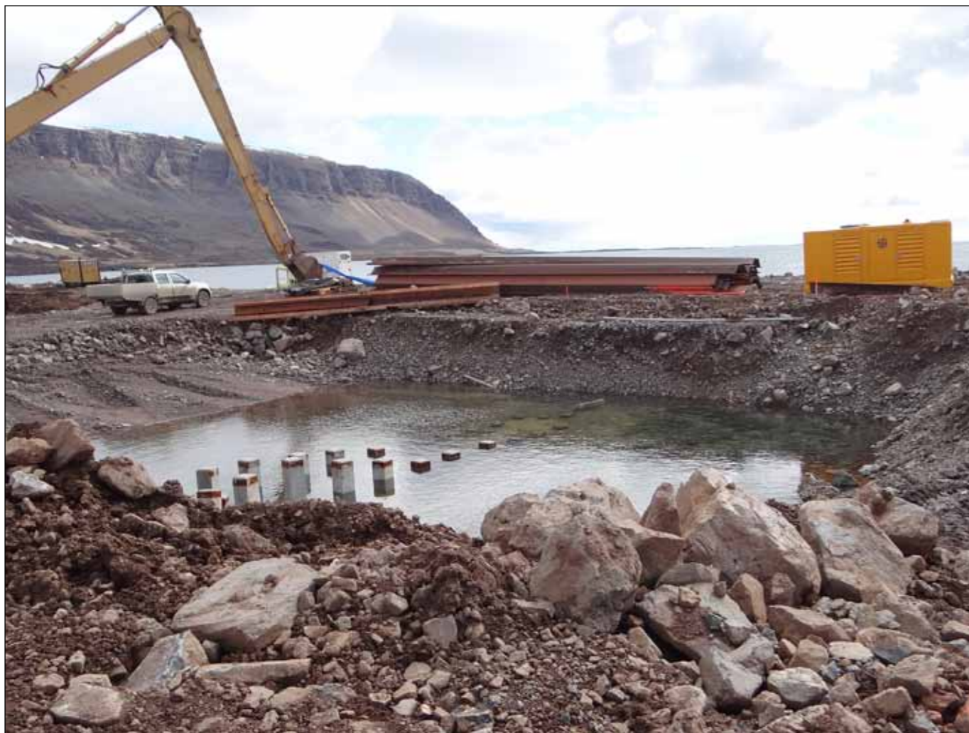
Seyptir staurar sem reknir voru niður undir sökla brúar á Kjálkafjörð. Stálpil er rekið niður utanum sökkulstæðið til að hægt sé að dæla upp úr því og vinna á þurru.
