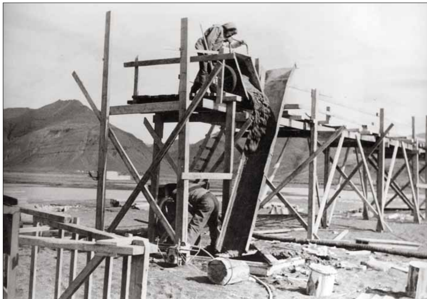
Brú yfir Hornafjarðarfjót í byggingu 1961. Á efri myndinni má sjá tvo fallhamra sem notaðir voru til að reka niður tréstauro. Á neðri myndinni má sjá að verið er að steypa sökkul. Sagað hefur verið ofan af staurinum í sökklinum og liggja topparnir til hliðar. Hjólbörurnar er talsvert stærri en þær sem allmennt voru notaðar í brúarvinnu.
