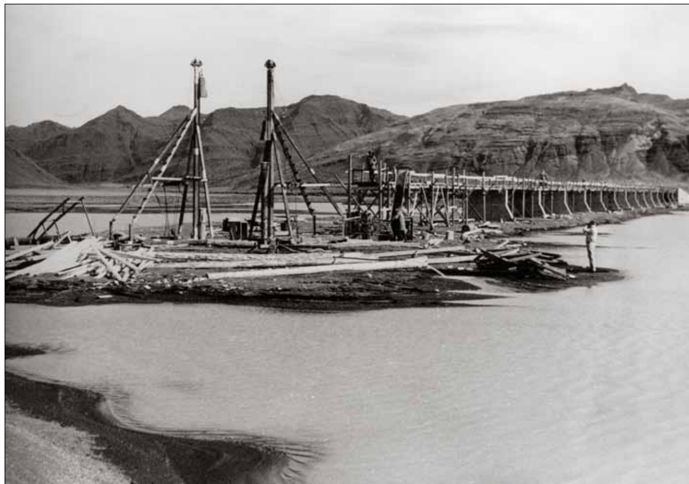
Brú yfir Hornafjarðarfjót í byggingu 1961. Á efri myndinni má sjá tvo fallhamra sem notaðir voru til að reka niður tréstauro. Á neðri myndinni má sjá að verið er að steypa sökkul. Sagað hefur verið ofan af staurinum í sökklinum og liggja topparnir til hliðar. Hjólbörurnar er talsvert stærri en þær sem allmennt voru notaðar í brúarvinnu.
