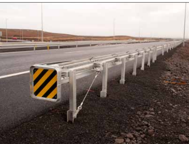
Réttur endafrágangur á vegrið við Reykjanesbraut. Vegrið fellur saman eins og harmonikka ef ekið er á það og stöðvar ökutækið um leið.
