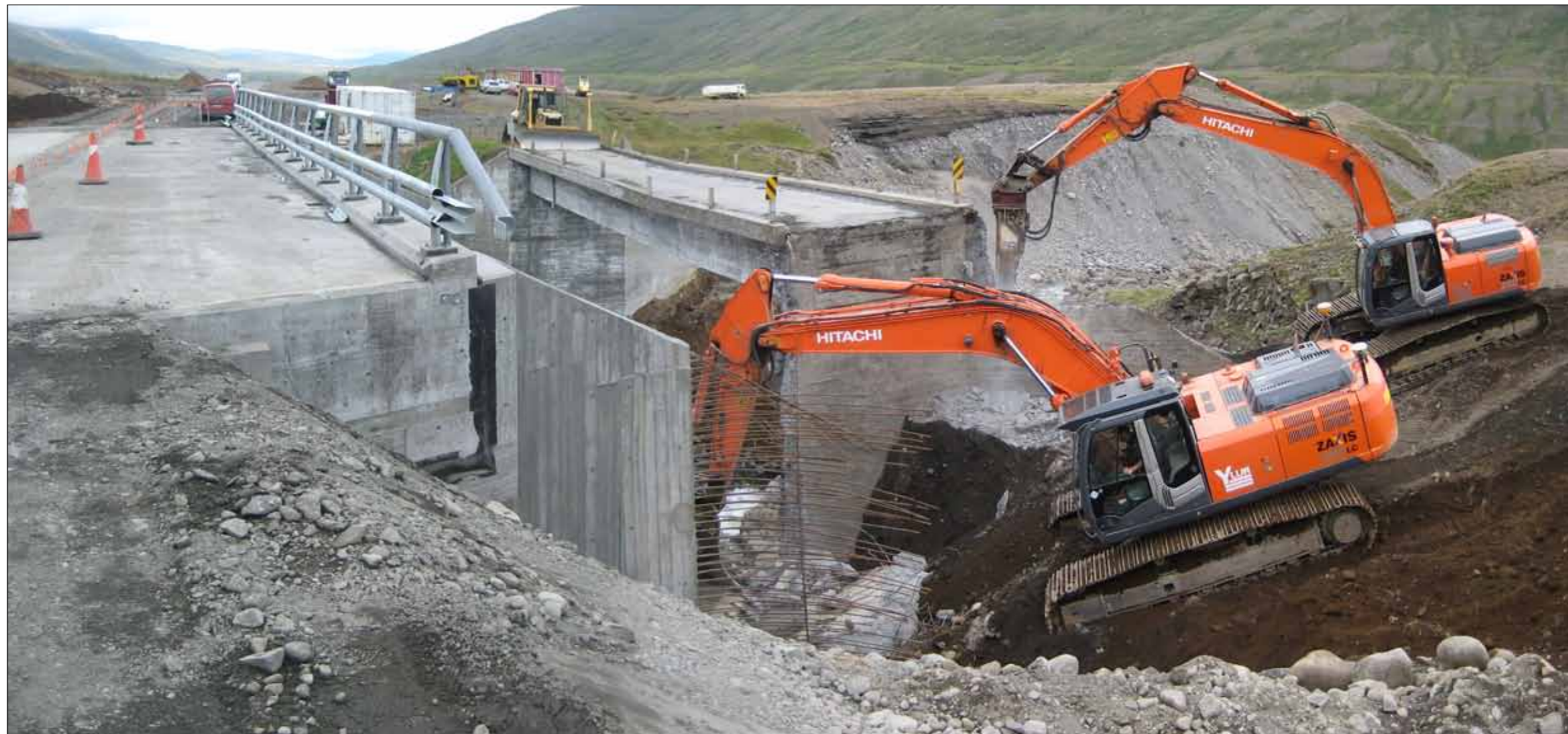
Hringvegur (1) í Jökuldal. Ný brú á Ystu-Rjúkandi. Verktaki: Ylur ehf. Unnið að niðurbroti eldri brúar 16. ágúst 2012. Vængur nýju brúarinnar er hálfbyggður þar sem eldri brúin var fyrir. Mynd: Ásrún Rudolfsdóttir (samsett í PhotoShop, VAI)
