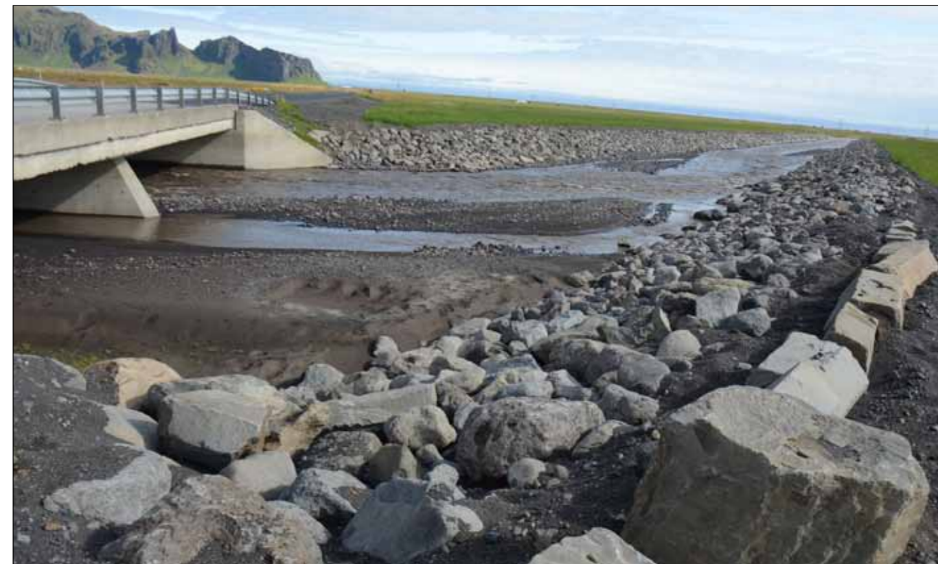
Svaðbælisá undir Eyjafjöllum hefur valdið vandræðum þar sem framburðurinn úr Eyjafjallajökli hefur hlaðist upp í farvegi. Nýgerður farvegur veldur meiri straumpunga og minna set sest í brúaropinun.
