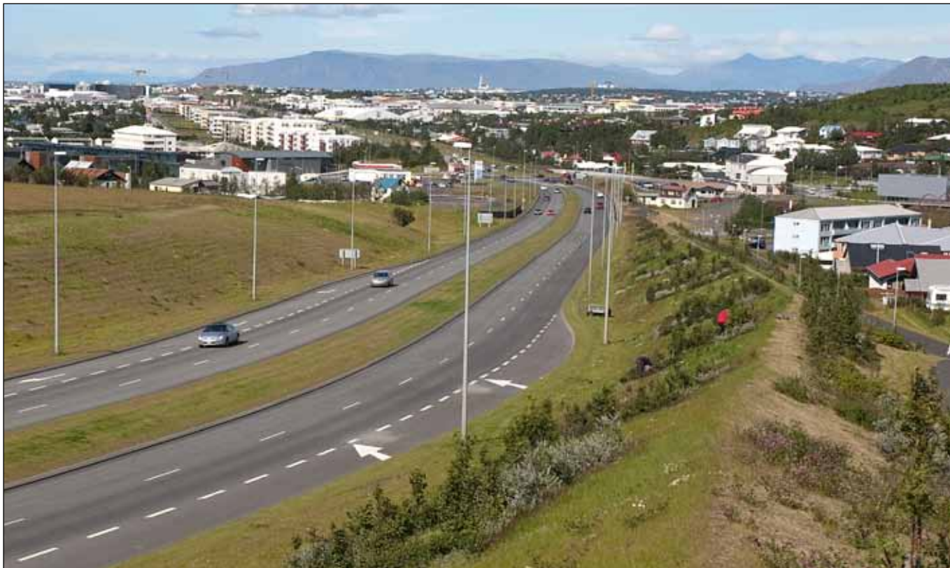
Hljóðmön við Reykjanesbraut í Hafnarfirði, byggð úr jarðvegi og gróðri bætt við. Myndin er tekin í ágúst 2006.
