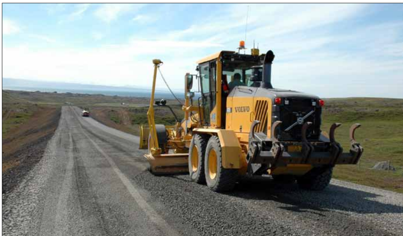
Framkvæmdir á Hófaskarðsleið.
