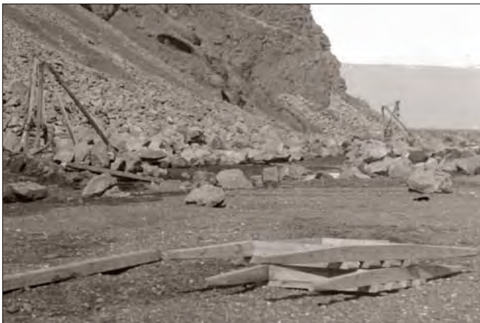
Grjótnám í Stóru-Dímon. Handbörur í forgrunni. Gálgar til að lyfta grjóti á vörubla.
