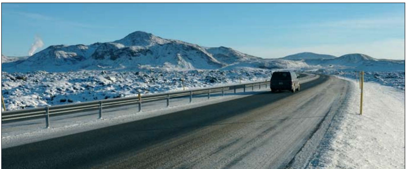
Hringvegur (1) í Svínahrauni. Víravegrið aðskilur akstursstefnur á þessum kafla, 2+1 vegur.
