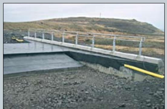
Frágangur brúardekks á Reykjanesbraut.
