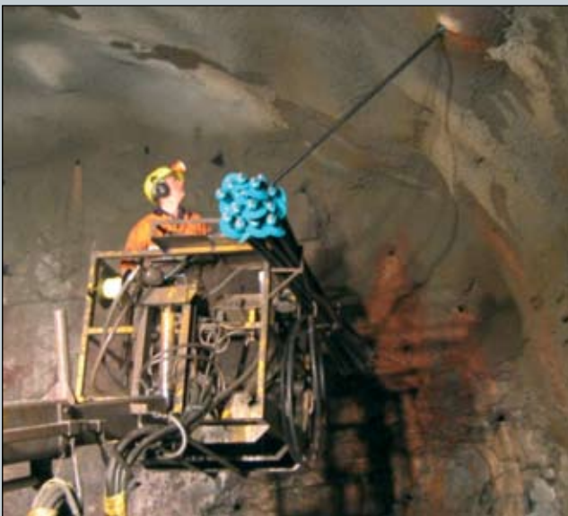
Borað fyrir bergbolta í Fáskrúðsfjarðargöngum.
