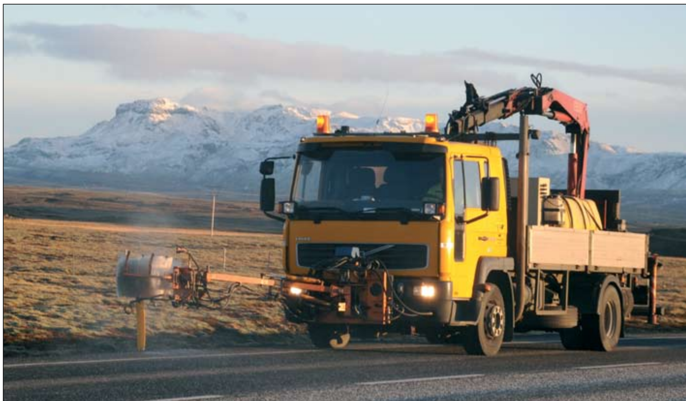
Hringvegur (1) í Svínahrauni. Vegstíkur hreinsaðar þann 12. janúar. Mikilvægur verkþáttur í skammdeginu.
