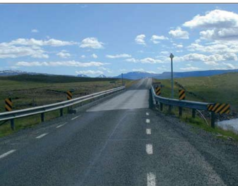
Búið er að setja upp viðvörunarljós við báða enda brúarinnar til að vara vegfarendur við einbreiðri brú.
