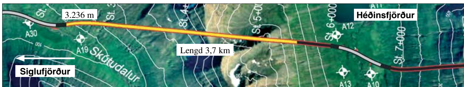
Staða framkvæmda við Héðinsfjarðargöng 21. jan. 2008. Búið er að sprengja 3.236 m í Siglufirði og 2.286 m í Ólafsfirði.
