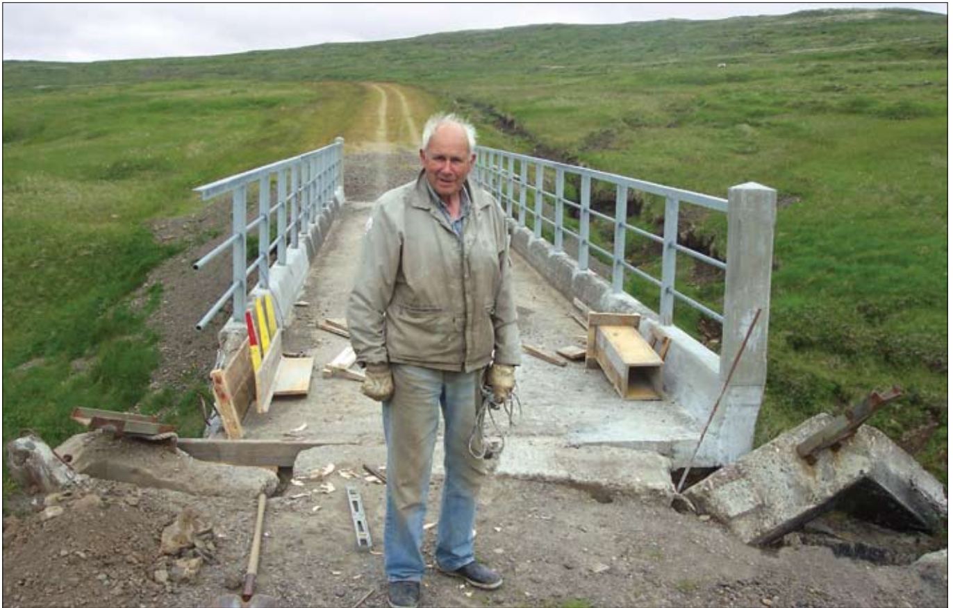
Geir Jónsson í Dalsmynni við endurbyggingu brúar yfir Miðdalsgil á Bröttubrekku. Sjá opnu.
