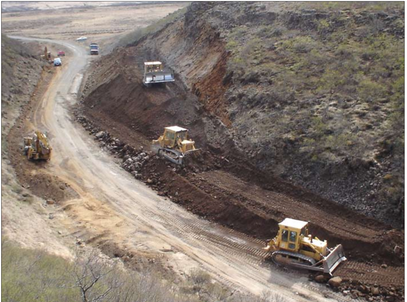
Vegagerð í Skolladal, skammt frá Húsafelli sumarið 2005. D8K jarðýta rípar glerhart setberg, en D7G og D6D ýta frá. Verktaki Jörvi hf. Mynd Reynir Ásberg.
