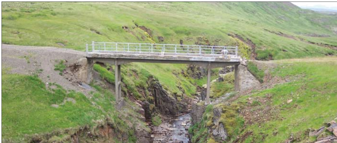
Gamla brúin yfir Miðdalsgil á Bröttubrekku. Geir Jónsson að störfum við endurbygginguna.
