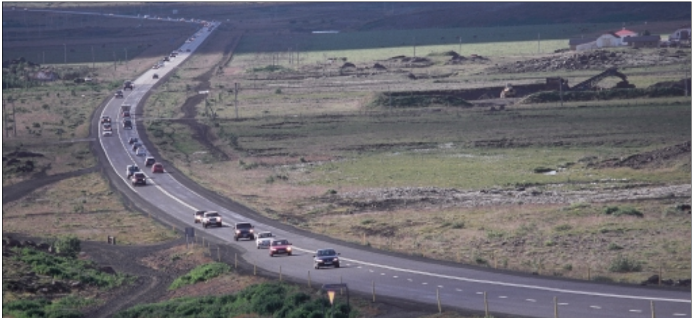
Suðurlandsvegur (Hringvegur 1) fyrir ofan Reykjavík. 2+1 vegur tekur við af 1+1 vegi. Þarna vantar víraleiðara til að greina á milli akstur Stefna að mati greinarhöfundar.
