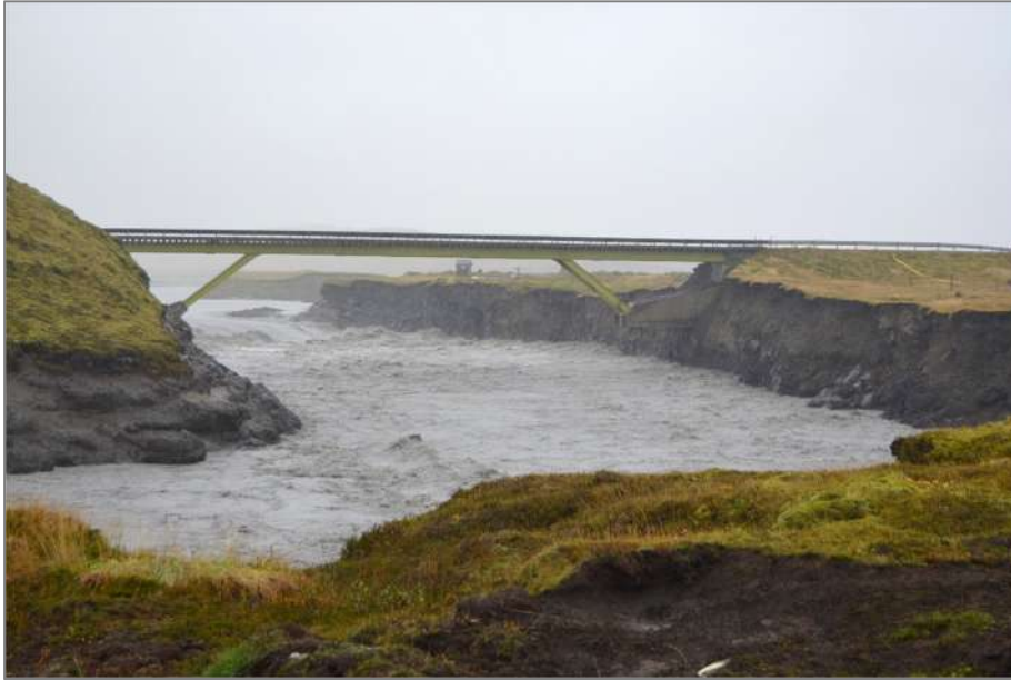
Mynd 1. Horft upp Eldvatn í október 2015 þegar Skaftárhlaup stóð yfir. Til hægri má sjá stöpul brúarinnar á austurbakkanum skaga út (ljósmynd: Guðmundur Valur Guðmundsson).
