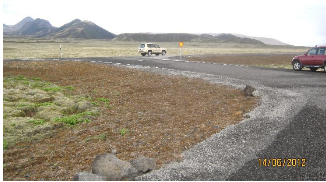
2. mynd. Við Lyngdalsheiðarveg. Svarðlagi dreift á yfirborð (ljósm. MBS).
