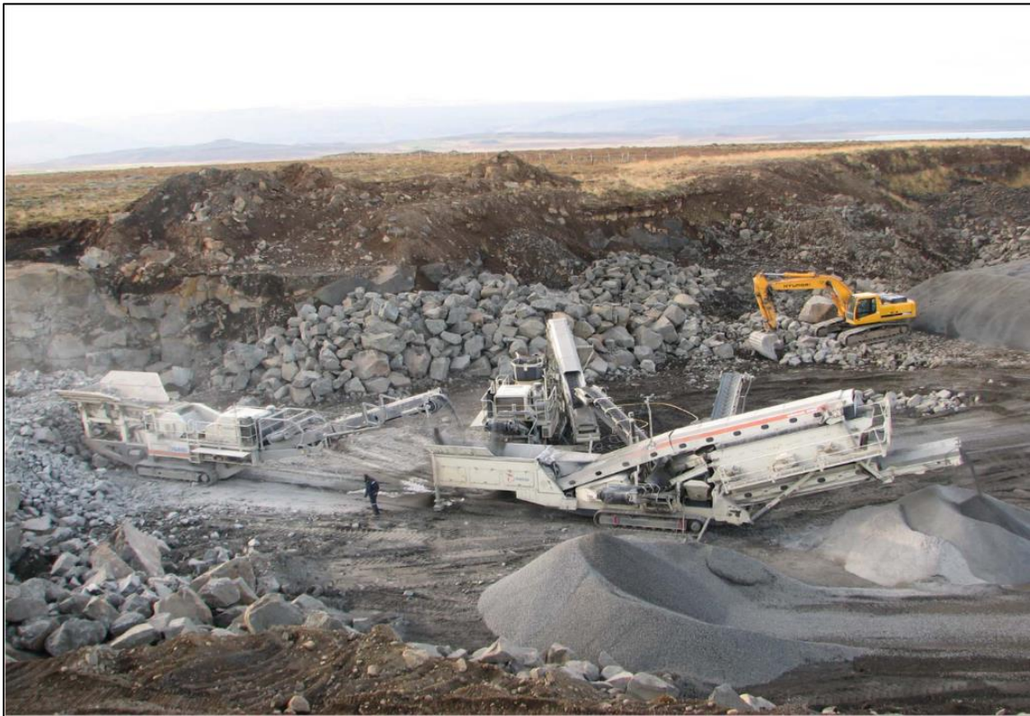
Mynd 1 Unnið að vinnslu klæðingarefnis í Uppsalanámu (Ljósmynd Hafdís Eygló Jónsdóttir).
