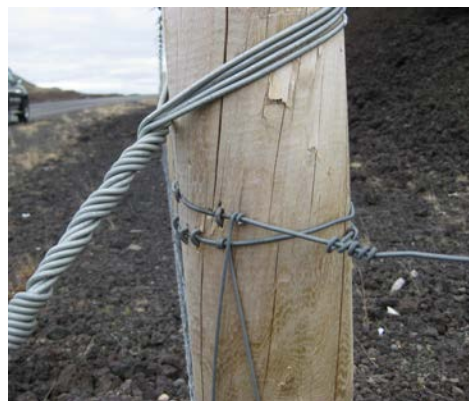
Mynd 5. Stög þurfa að vera fjórföld, vel vafin rétt fyrir ofan girðingastrengi. (Ljósmynd: Grétar Einarsson)
