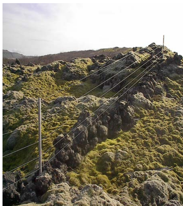
Mynd 15. Undirgirðingar og undirhleðslur eiga að ver ótengdar aðalgirðingu. Myndin sýnir hleðslu úr hraungrýti. (Ljósmynd Grétar Einarsson).
