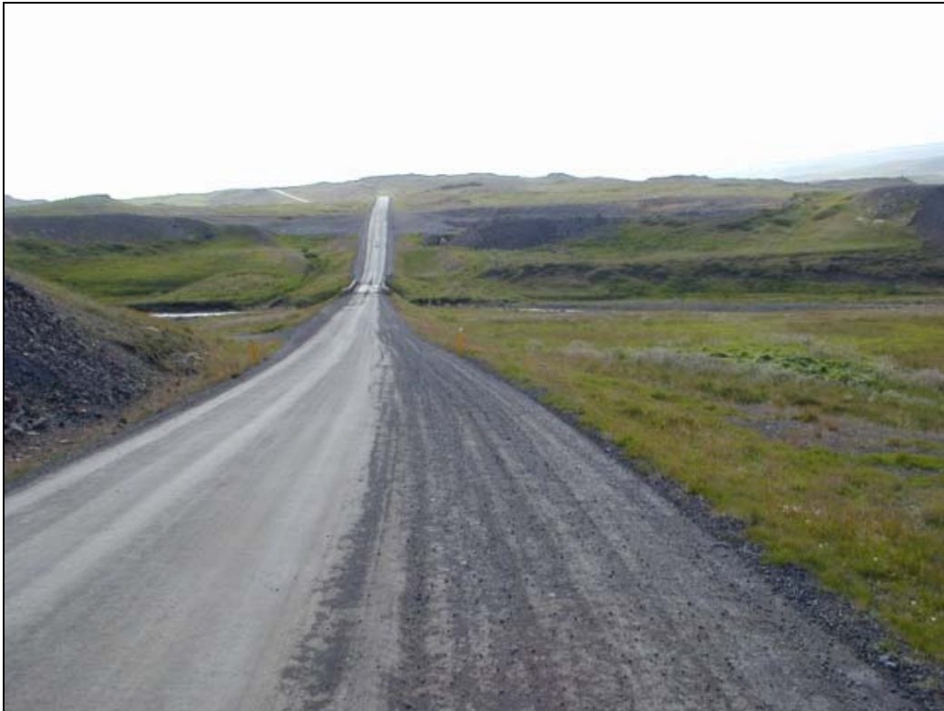
Mynd 1. Horft vestur Upphéraðsveg að brú yfir Ormarsstaðaá
