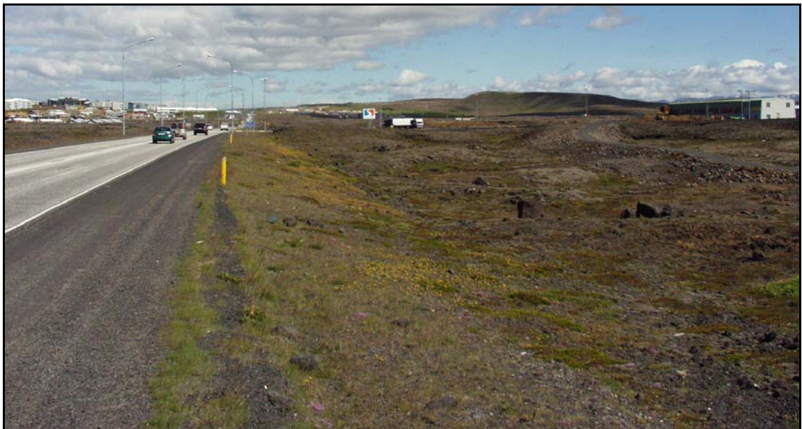
Mynd 4.1. Ljósmynd af hluta fyrirhugaðs framkvæmdasvæðis vegna breikkunar Reykjanesbrautar. Horft er í norðaustur átt og sést hluti byggðar á Hvaleyrarholti norðan vegar og hluti Valla sunnan vegar. (Ljósmynd: Hönnun hf.)
