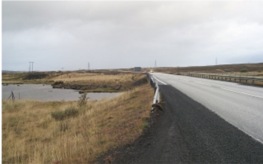
Mynd 13. Brúin yfir Hólmsá. Vegrið er beygt niður og virkar sem stökkpallur
