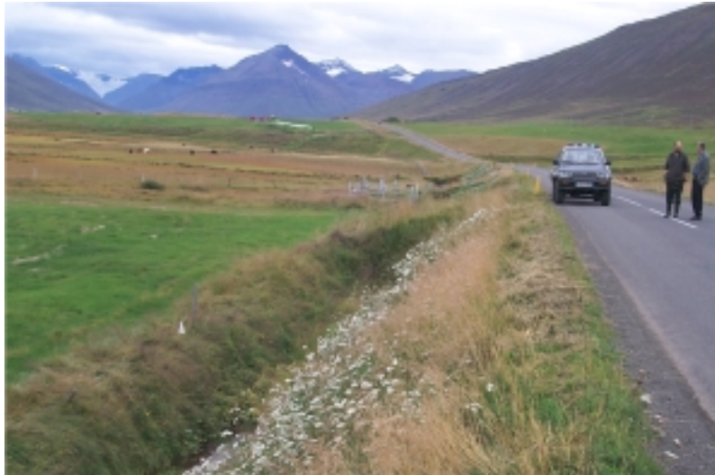
Mynd 10. Svarfaðardalsvegur norðan við Hrafnstaði. Breidd 5 metrar.
