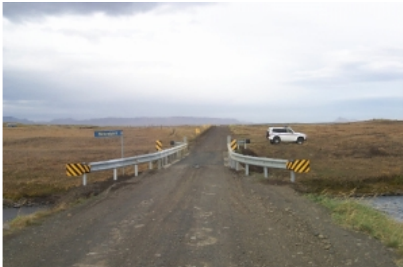
Mynd 14. Brúin yfir Hólsselskíl. Myndin er tekin eftir að brúin var lagfærð eftir slysi sem þar varð sumarið 2000
