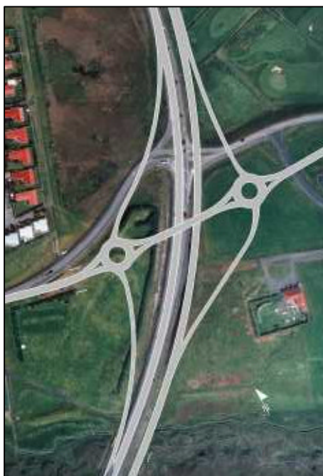
Mynd 2.4: Mislæg vegamót Vífilsstaðavegar og Reykjanesbrautar
