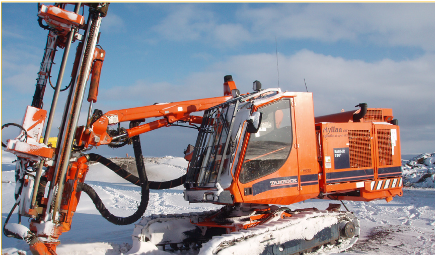
Unnið við borun í bergskeringu (RJ).
