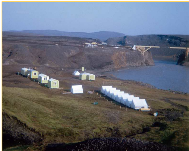
Bygging brúar yfir Tungnaá við Sigöldu (VAI).
