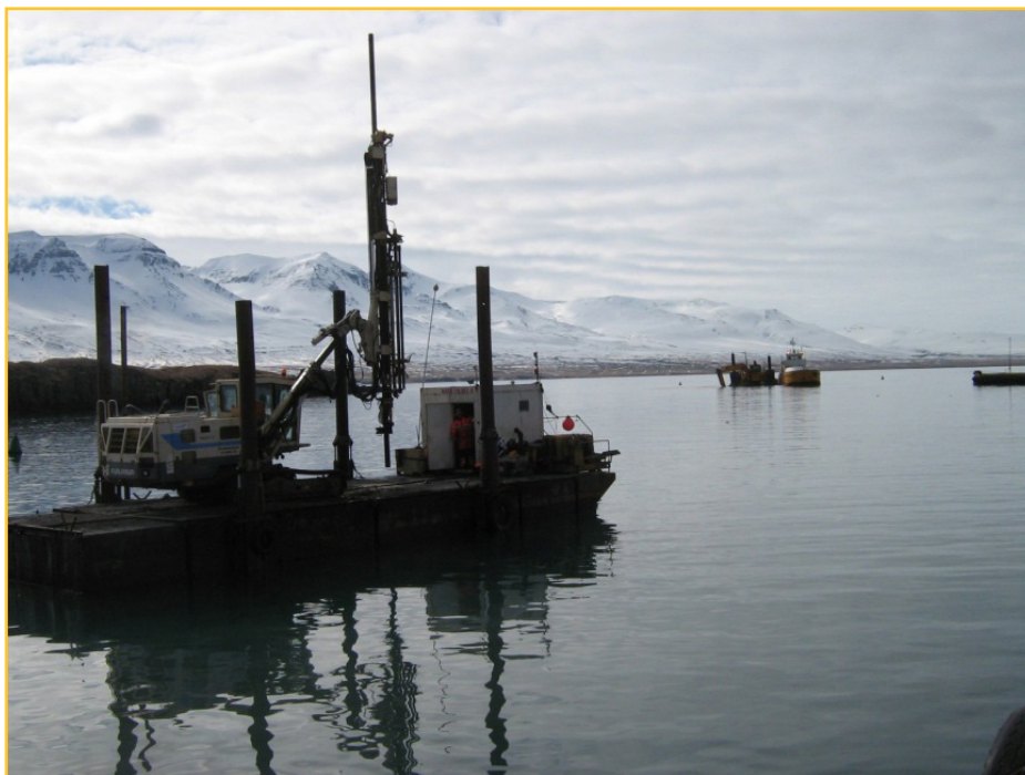
Unnið að dýpkun í Vopnafjarðarhöfn.
