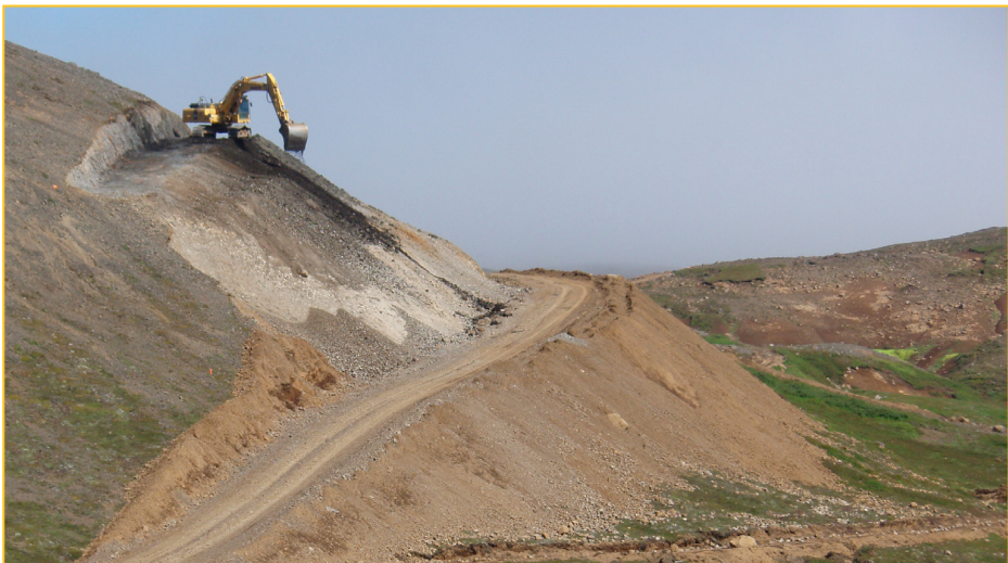
Unnið við vegagerð í Hólfaskarði (RJ).
