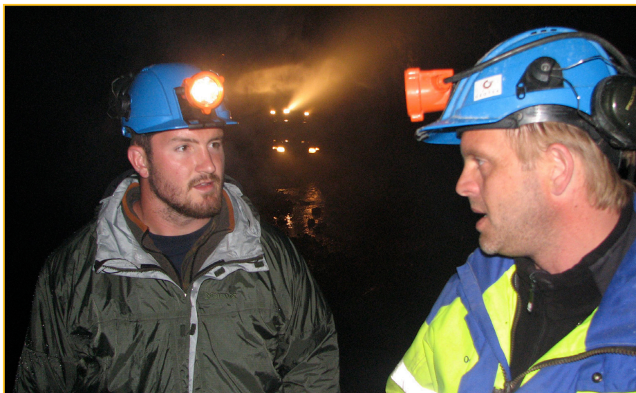
Við vinnu í Héðinsfjarðargöngum (HEI)
