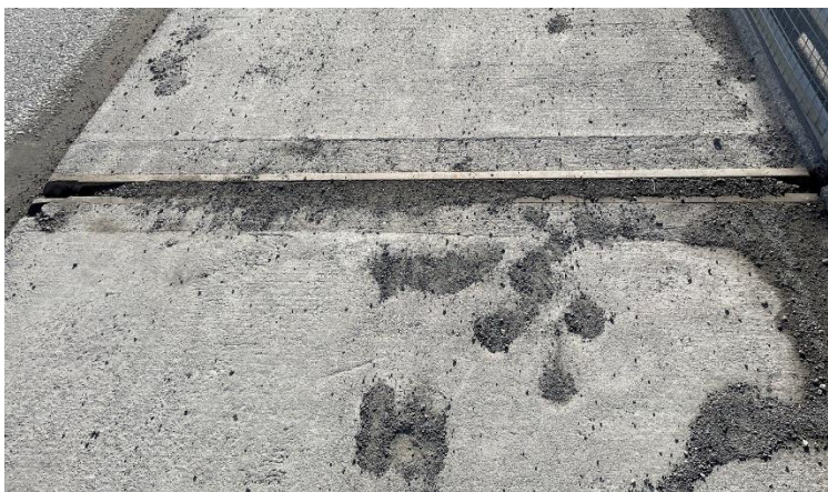
MYND 20 Brú yfir Vesturlandsveg á Víkurvegi, þensluraufin fyrir gangandi vegfarendur full af sandi, mars 2021.
