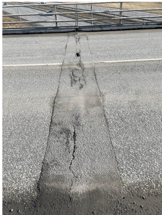
MYND 18 Brú yfir Vesturlandsveg á Víkurvegi, þensluraufin sunnan megin til vinstri og norðan megin til hægri, mynd tekin í mars 2021.
