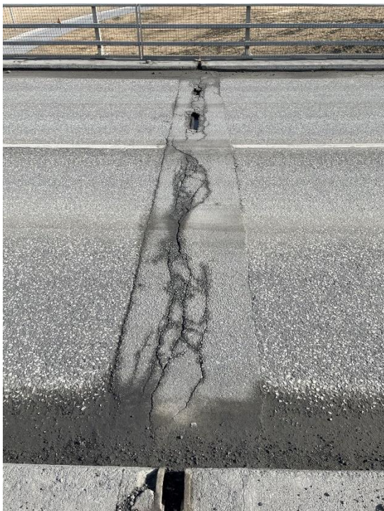
MYND 18 Brú yfir Vesturlandsveg á Víkurvegi, þensluraufin sunnan megin til vinstri og norðan megin til hægri, mynd tekin í mars 2021.
