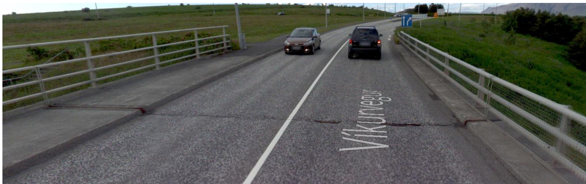
MYND 11 Brú yfir Vesturlandsveg á Víkurvegi, fúgan norðan megin er illa farin, mynd tekin af ja.is (júlí 2019).
