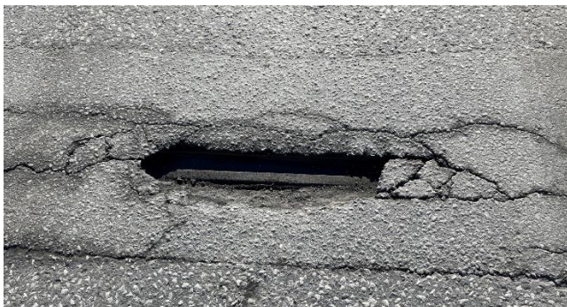
MYND 19 Brú yfir Vesturlandsveg á Víkurvegi, dýpstu holurnar ná niður í þensluraufina, mars 2021.
