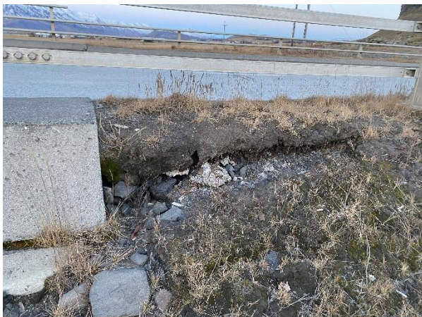
MYND 15 Greinilegt sig á vegfyllingunni við suðvestur horn brúarinnar á brúnni á Korpúlfsstaðavegi
