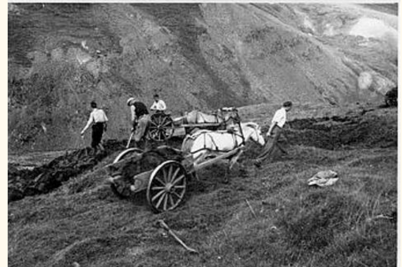
Hakinn og skóflan voru aðalvertfærin, sem notuð voru við vegagerð áður fyrr.
