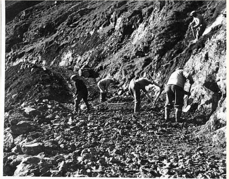
Hakinn og skóflan voru aðalvertfærin, sem notuð voru við vegagerð áður fyrr.
