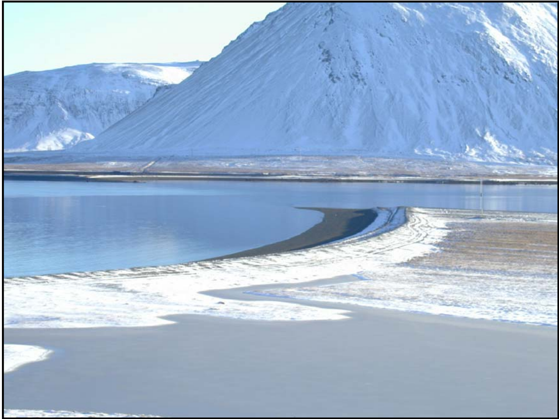
Mynd 10. Fyrirhugað brúarstæði yfir Kolgrafafjörð, útsýni frá Hjarðarbólsodda
