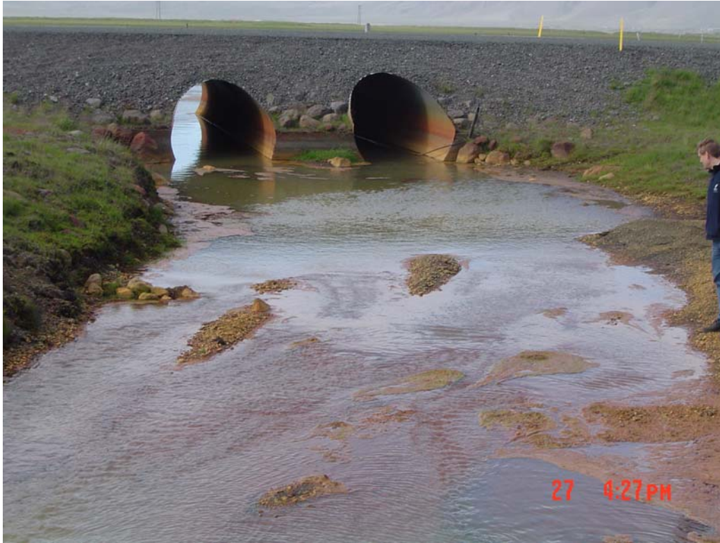
2. mynd. Brunnhólsá ræsi undir núverandi veg.
