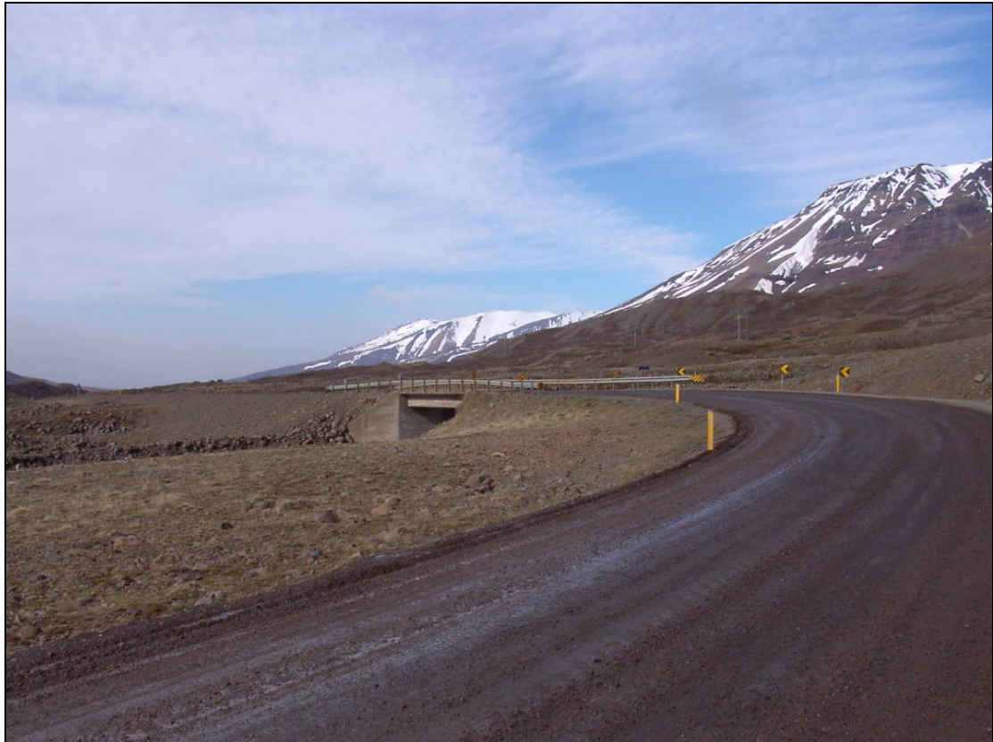
Mynd 1. Horft til norðurs að brúnni yfir Vatnsdalsá. Kröpp beygja er sunnan við brúna.
