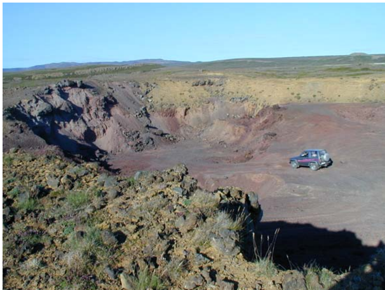
Mynd 8.3 Náma A, Presthólanáma. Myndin er tekin til norðurs í vesturhluta námunnar. Vinstra megin á myndinni er námustálið um 8-9 m hátt. Á ljósbrúna svæðinu hefur verið gengið frá jöðrum að hluta.
