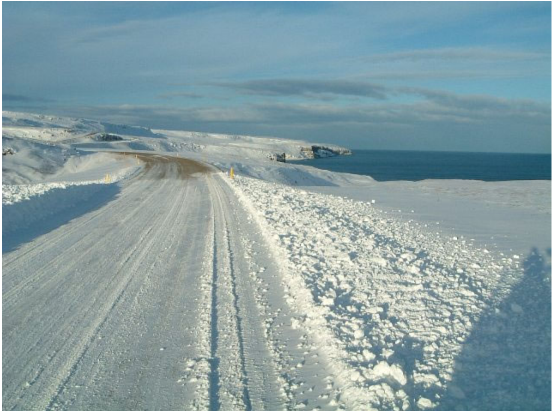
Mynd 6. Myndin sýnir hversu skörp skil eru á milli snævar á vegi og auðs vegar. Þetta gerist við mörk fyllinga og skeringa. Myndin er tekin á nýjum vegi á Tjörnesi skammt ofan við Hafnarbrekku. Ljós. Árni Jónsson, 02/2004.
