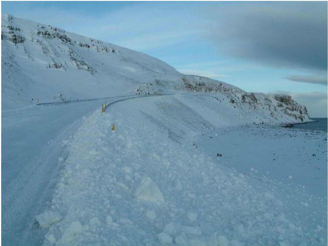
Mynd 8. Myndin sýnir hvernig snjór safnast inn á veg á háum fyllingum þar sem vegrið eru og fláar brattir. Hér er nýbúið að ryðja veginn en nóttina áður sátu all nokkrir bílar þ.á.m. jeppar fastir í snjó sem skóf af vegriðinu, inn á veginn, frá hægri til vinstri. Myndin er tekin upp Hafnarbrekku í Kelduhverfi. Ljós. Arni Jónsson, 02/2004.
