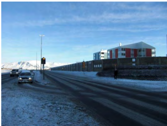
Mynd3-11: Steypur veggur við Sæbraut
