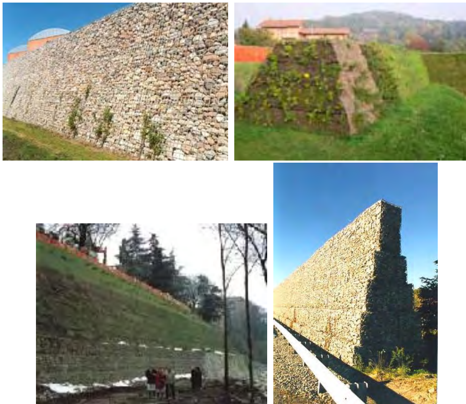
Mynd 3-5: Dæmi um netakassa sem er hlaðin upp og hægt að setja 8
