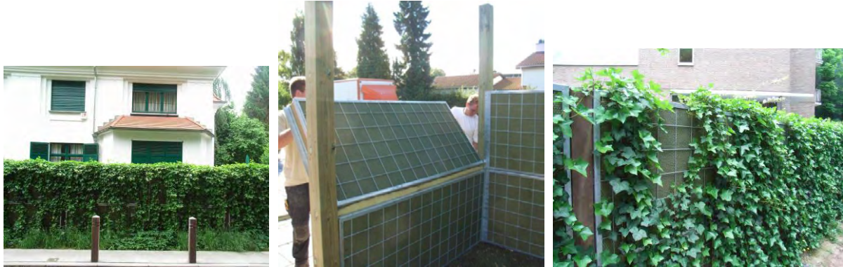
Mynd3-6: Dæmi um einingar sem hægt er að fela með gróðri. NoiStop 9 .
