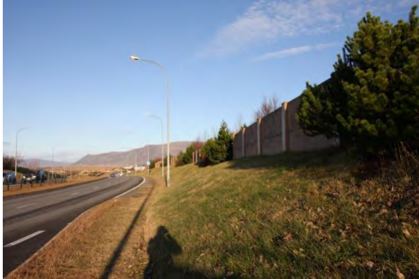
Mynd3-13 Steyptur veggur við Gullinbrú
