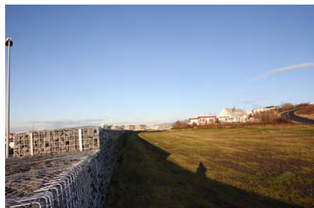
Mynd 3-9: Styrkt mön, grindur við Reykjanesbraut, skjólmegin
