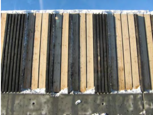
Mynd 3-16: Timburveggur í Garðbæ, með steyp undirstöðum.
