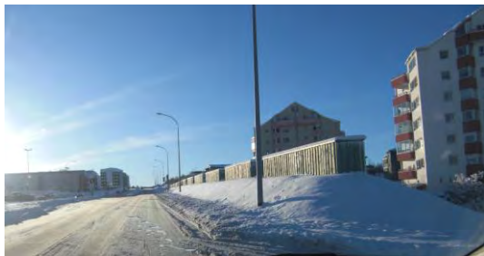
Mynd 3-18: Timburveggur ofan á jarðvegsmön í Kóp
