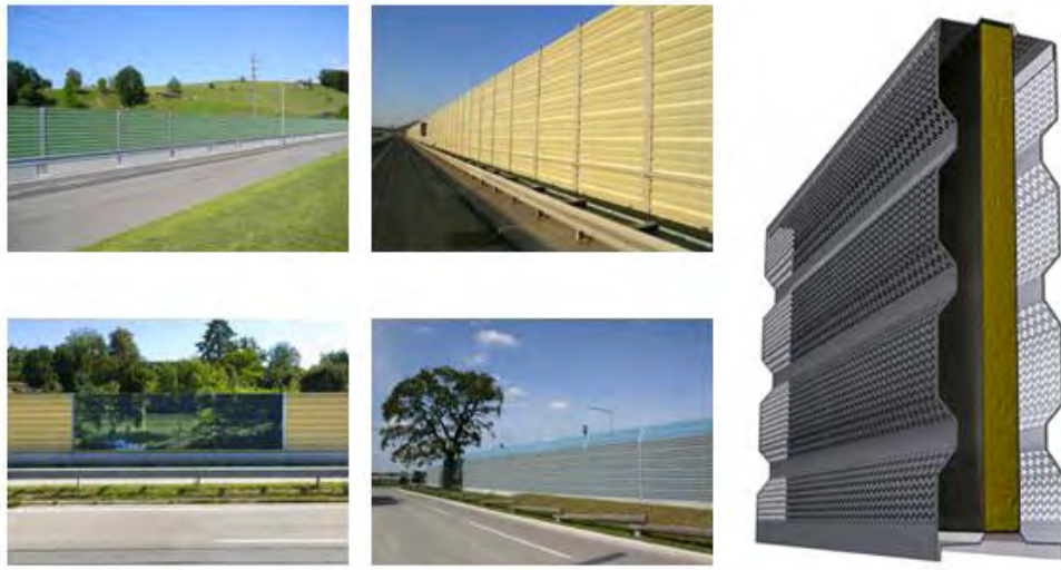
Mynd 3-2 Uppbygging á hefðbundnum hljóðisogavegg. Gataðar álplötur yst, hljóðdúkur og loks steinull innst. 5
