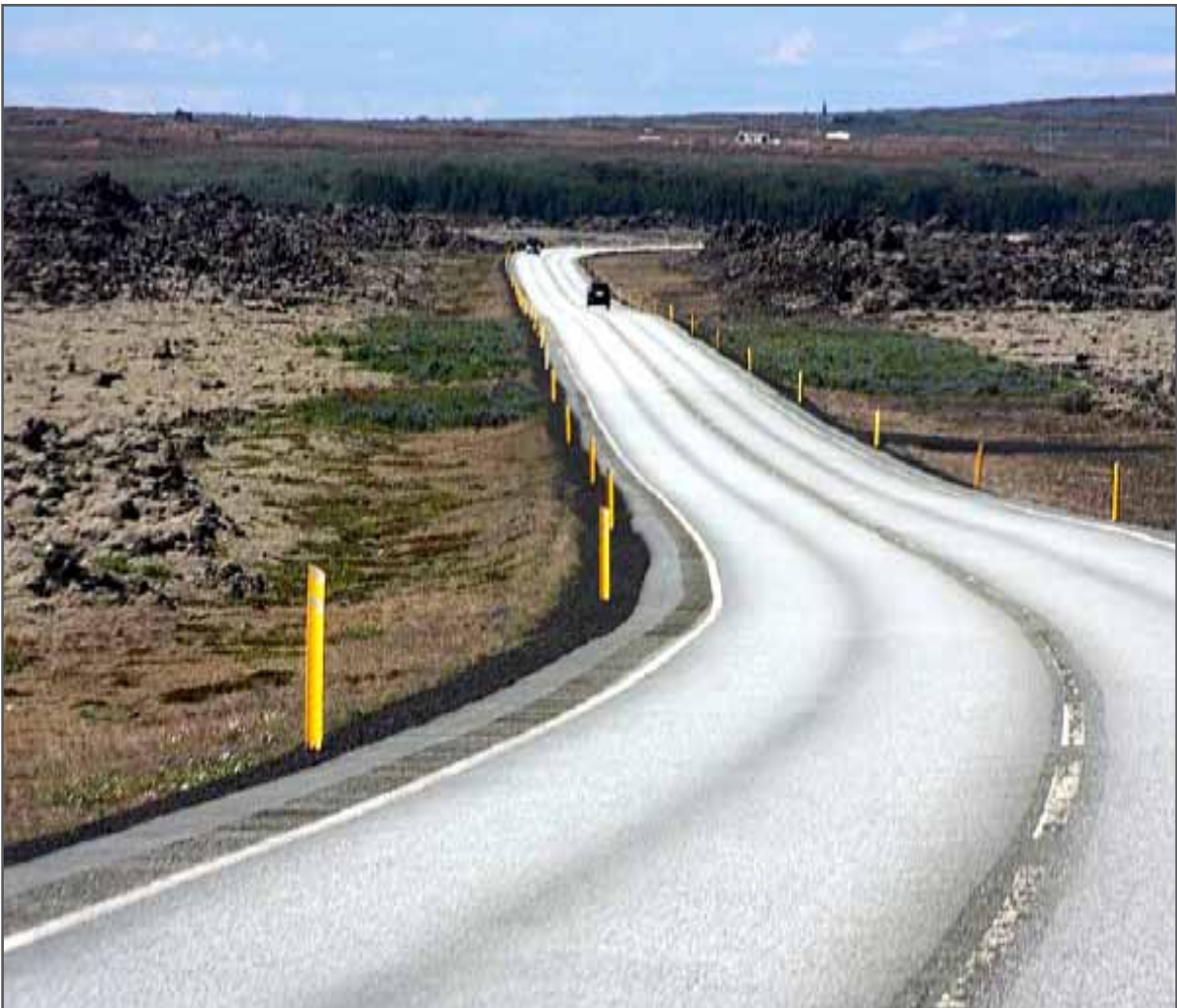
Mynd 325: Grindavíkurvegurinn árið 2012 – norðan Gíghæðar. Höfundur.
