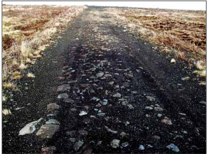
Mynd 276: Vagnvegurinn austan Þorbjarnarfells. Enn (árið 2012) má sjá hvernig hann var „púkkaður“ á síðustu metrunum til Grindavíkur. Höfundur.
