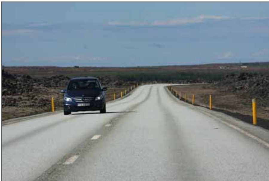
Mynd 319: Grindavíkurvegurinn árið 2012. Höfundur.
