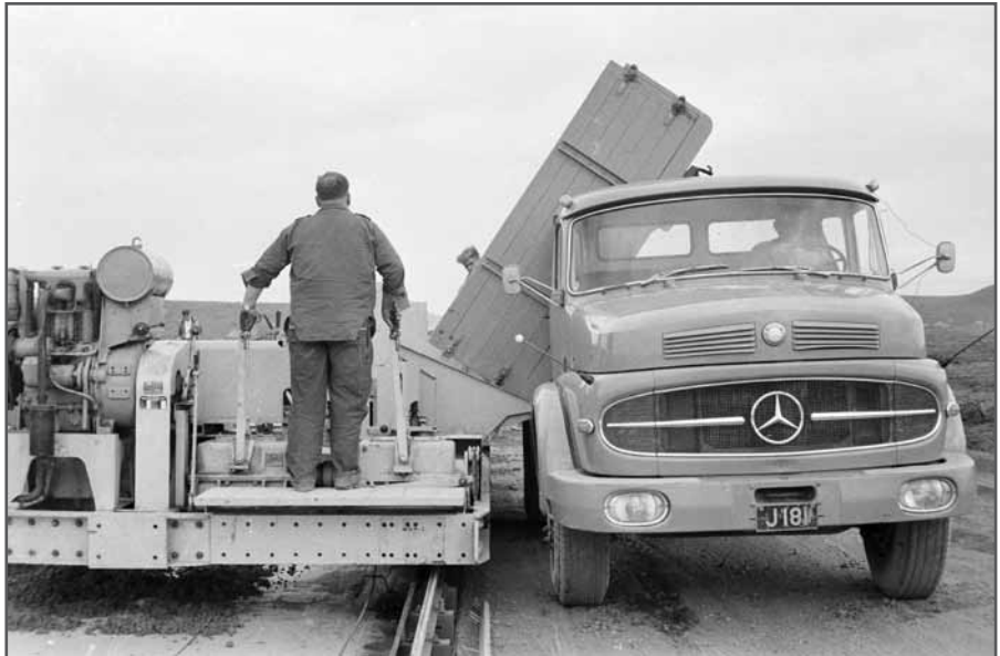
Mynd 249: 10. júlí 1963, vinna við lagningu Keflavíkurveg, Reykjanesbrautar. Maður stendur á steypuvél sem notuð var til að steypa veginn, vélin gekk á járnbraut þegar steyp var. Vörubíll losar hlass í vélina. Sveinn Þormóðsson / www.ljosmyndasafn.reykjavik.is .
