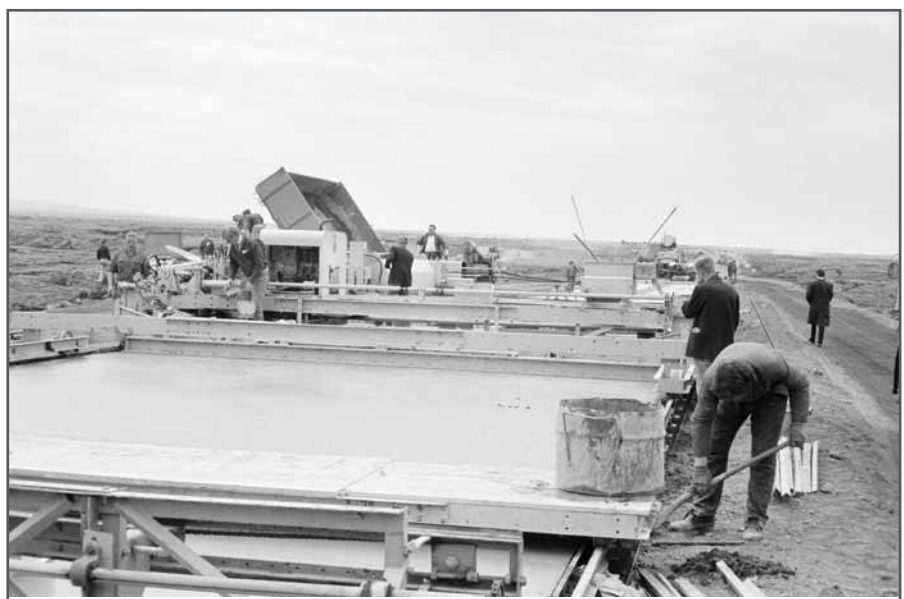
Mynd 248: 10. júlí 1963. Unnið við að steypa Keflavíkurvegin 1963. Menn vinna við steypuvél sem notuð var til að steypa veginn, vélin gekk á brautarteinum þegar steyp var. Sveinn Þormóðsson / www.ljosmyndasafn.reykjavik.is .
