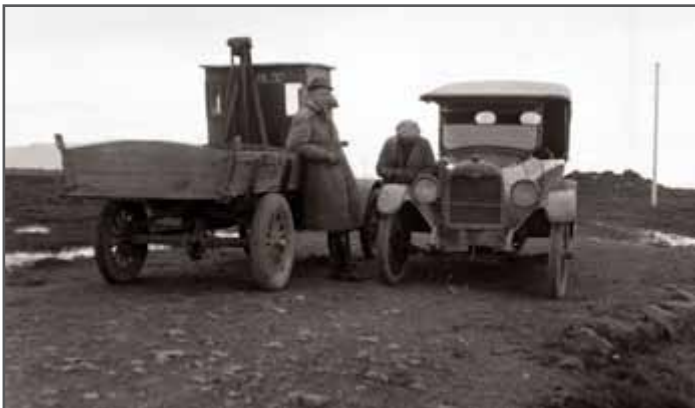
Mynd 212: Einn af vörubílum Vegagerðarinnar. Vel má sjá sturtubúnaðinn. Geir Zoëga.
