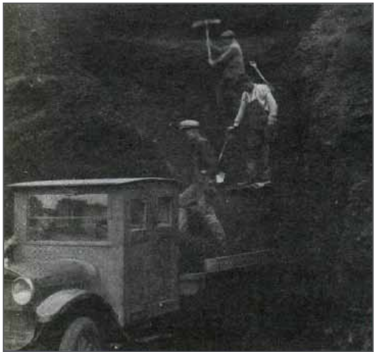
Mynd 209: Vegagerð með handmökstri. Geir Zoëga.
