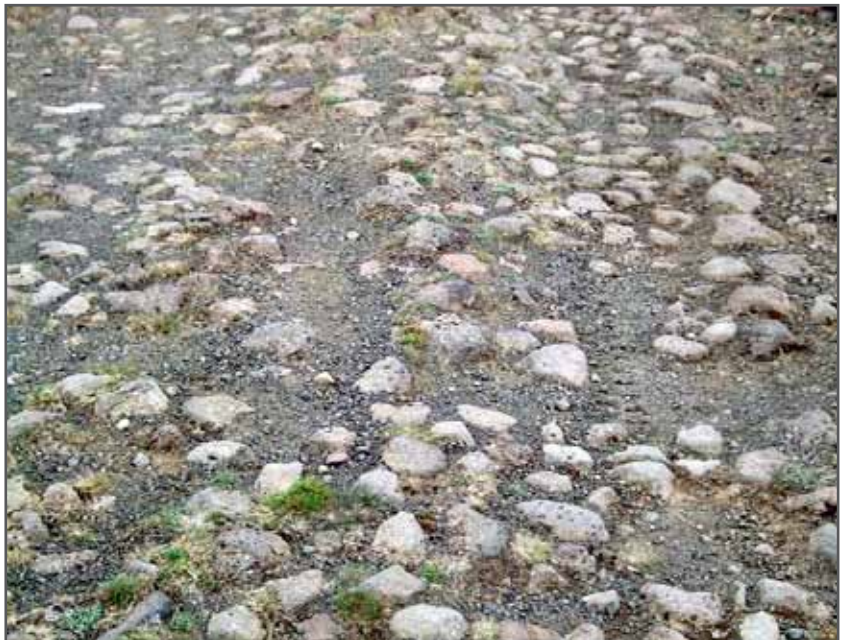
Mynd 231: Vandað var til vagnvegjar Suðurnesjavegarins. Hann var svo til allur „púkkaður“, eins og sjá má. Myndin er tekin á Stapanum. Höfundur.
