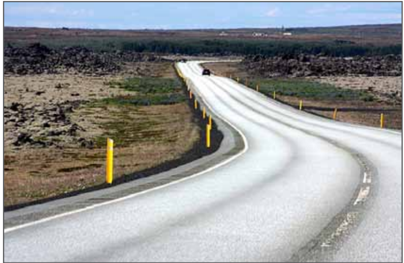
Mynd 320: Grindavíkurvegurinn árið 2012, norðan Gíghæðar. Höfundur.
