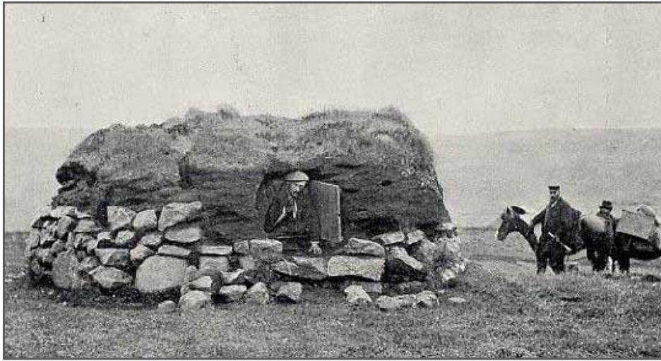
Mynd 52: Sæluhús við Aðalsmannsvötn á Sprengisandsleið. Daniel Bruun.
